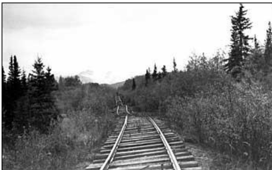
Figura 1.33. Ferrovia costruita su permafrost vicino Strelna in Alaska danneggiata dal disgelo del permafrost.
