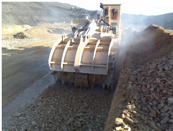
Figura 1.12 Sottofondi stradali non legati.
