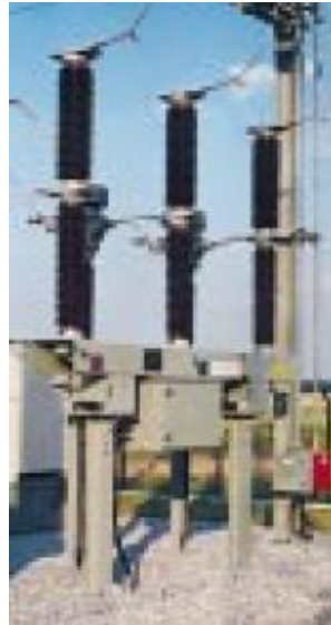
Figura 2-6: struttura in acciaio di un interruttore
