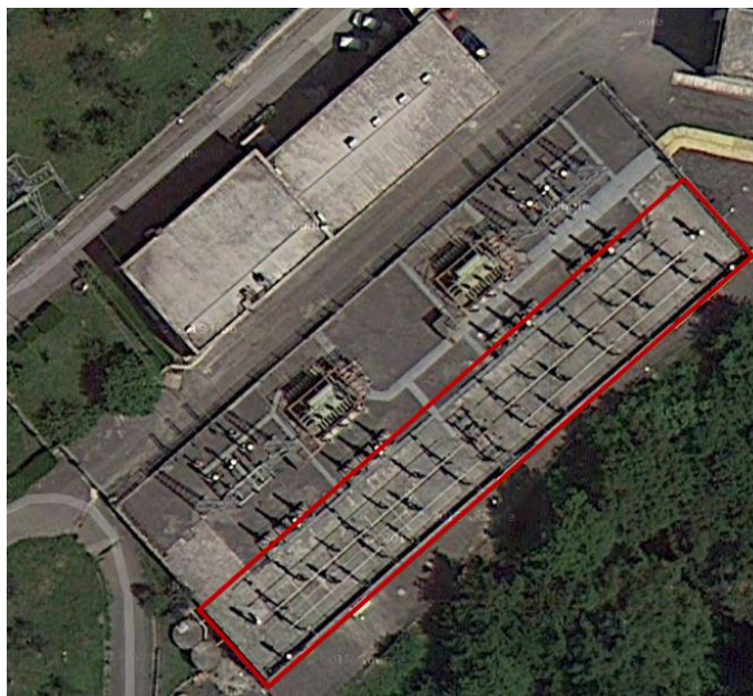
Figura 6-17: area a rischio stabilità
