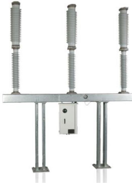
Figura 1-1: LTB (Live Tank Breaker) 145 kV
