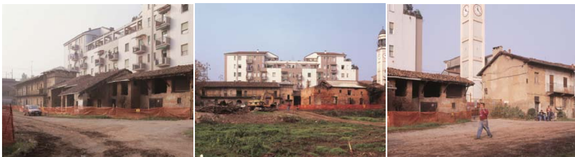
Figura 4. La Cascina Conti prima dell'inizio dei lavori di recupero. Fonte: Bando del Concorso di progettazione Arcate di greco, Allegato 07, Rilievo Fotografico
