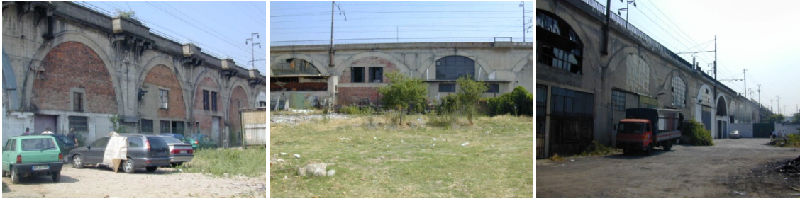
Figura 2. I fornici prima della bonifica di RFI. Fonte: Bando del Concorso di progettazione Arcate di greco, Allegato 07, Rilievo Fotografico
