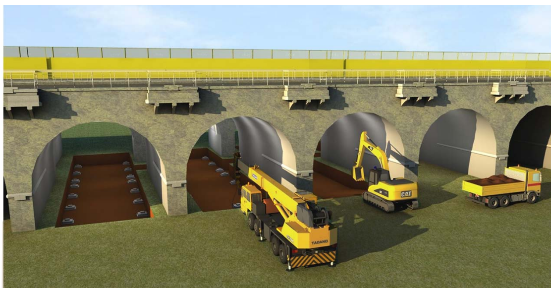
Figura 126. Vista relativa alla fase di scavo e posa dei plinti di fondazione, stralcio della tavola 6.05 b, Fasi costruttive . Fonte: elaborazione grafica dell'autore
