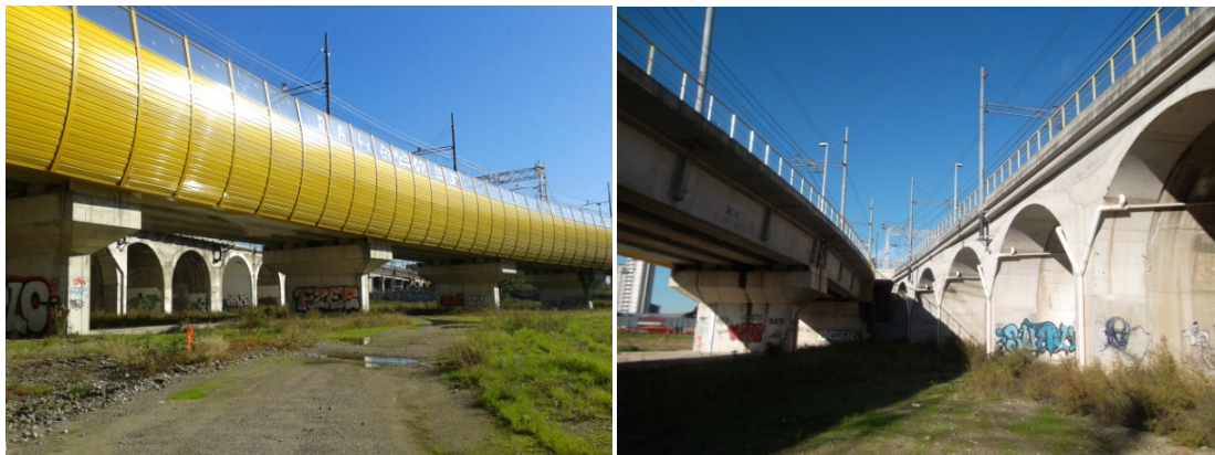
Figura 50. Nuovo viadotto Milano Centrale-Malpensa. Fonte: foto dell'autore
