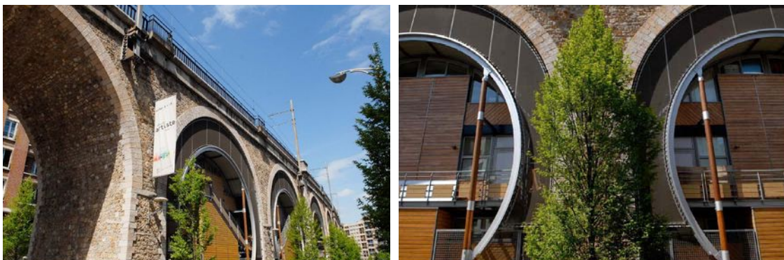
Figura 78. L'uso della rete nel progetto di Dubosc e Landonsky Les Arches a Issy-les-Moulineaux in Francia. Fonte: www.blogarchiphot.com
