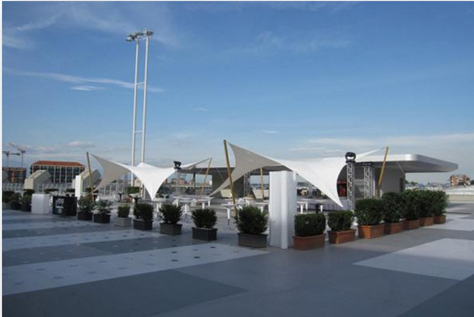
Figura 43 - Tipico esempio di coperture a vela con alternanza tra punti di giunzione alti e punti bassi
