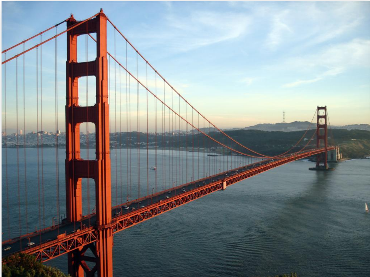
Figura 7 – Il Golden Gate Bridge di San Francisco: tipico esempio di ponte sospeso in cui le due funi stabilizzanti sorreggono i pendini, i quali fungono da collegamento con l'impalcato (immagine tratta da www.buidup.it ).
