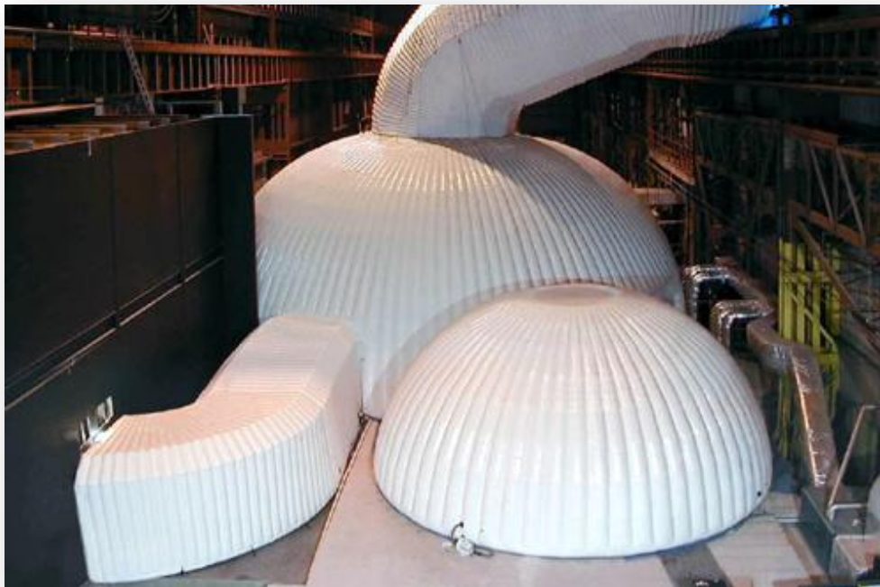
Figura 77 - Ristorante gonfiabile e centro educativo, Rotherham, Regno Unito, Lindstrand Technologies (immagine tratta da Zanelli, 2007)
