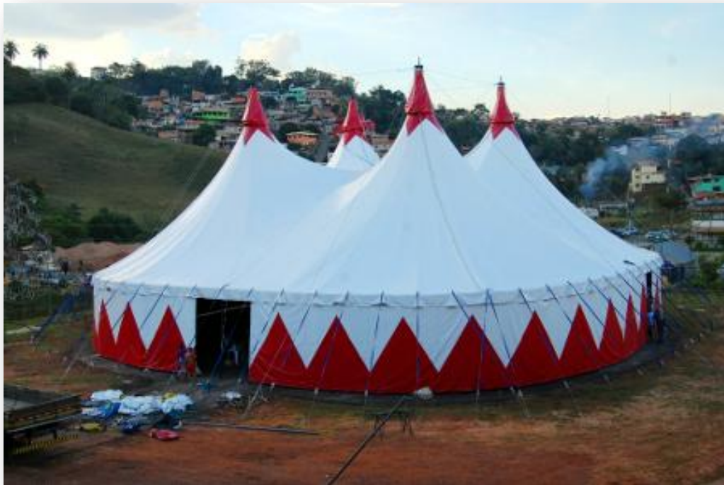
Figura 33 - Il tendone da circo è uno dei più chiari esempi di come uno dei principali obiettivi nell'impiego di strutture a membrana sia la facilità di assemblaggio e la portatilità della struttura (immagine tratta da it.wikipedia.org ).
