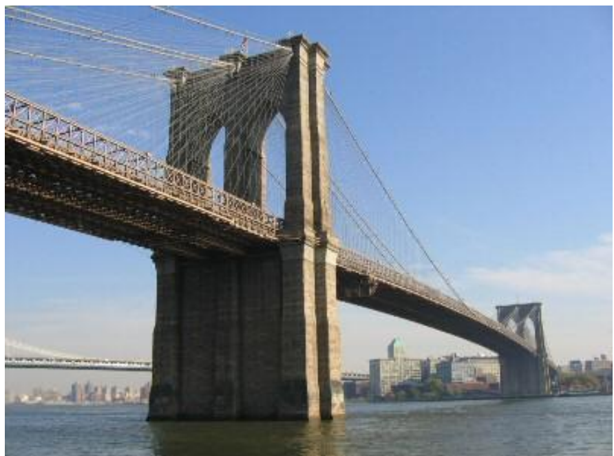
Figura 9 – Ponte di Brooklyn, New York, A. Roebling, 1867; il ponte annovera un nuovo sistema di fili a funi parallele (immagine tratta da www.buidup.it ).
