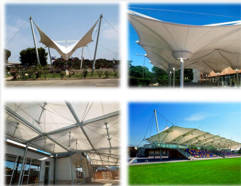
Figura 64 - Le principali tipologie di alberi per il sostegno delle membrane; Partendo da sinistra: a- struttura con alberi di bordo; b- struttura con alberi interni; c- struttura con alberi sospesi; d- struttura con alberi esterni. (immagine tratta da Google immagini)
