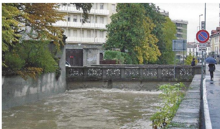
Figura 2-6: il ramo minore del Lambro, che attraversa Monza, durante la piena del 1° novembre 2010 non riesce a passare sotto il ponte di via Luigi Villa (foto di Bruno Grillini, fonte: (Centro Meteorologico Lombardo 2011)).
