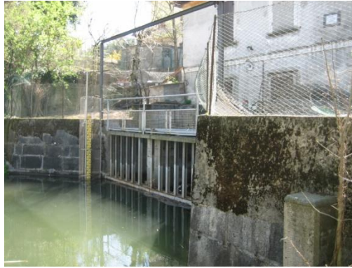
Figura 6-11: paratoia di regolazione del cavo Diotti.
