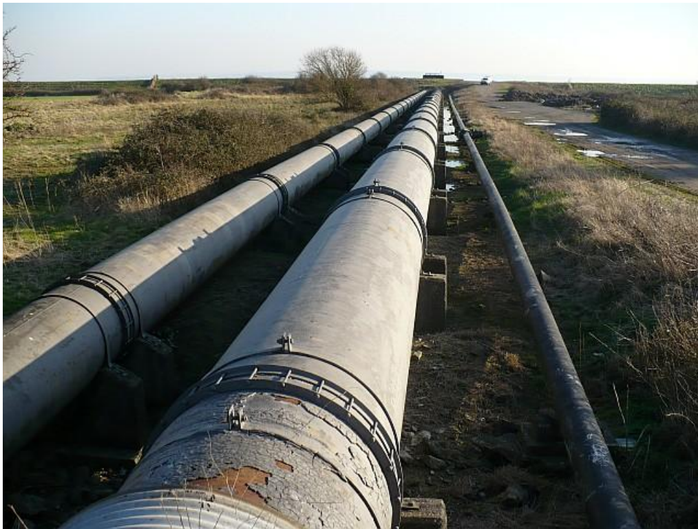
Figura 2.1: condotta continua in acciaio con giunti meccanici. Foto di Robin Drayton, geograph.org.uk
