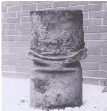
Figura 2.19: buckling in una condotta di acciaio. Fonte: Suzuki N.,2003
