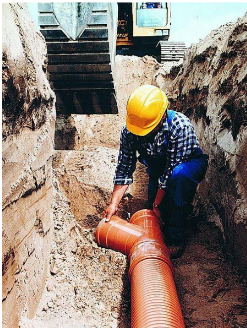
Figura 2.4: posa di condotte in PVC per la rete fognaria. Fonte: www.pvc4pipes.com
