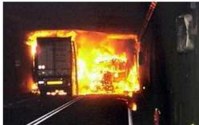
Figura 4: Incendio all'interno della Galleria del San Gottardo, 24 ottobre 2001
