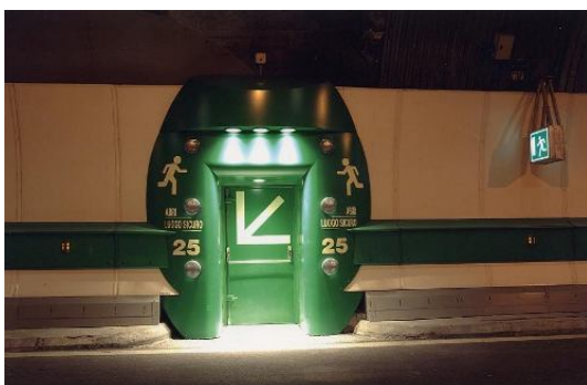
Figura 20: Esempio di via di fuga con relativa segnaletica
