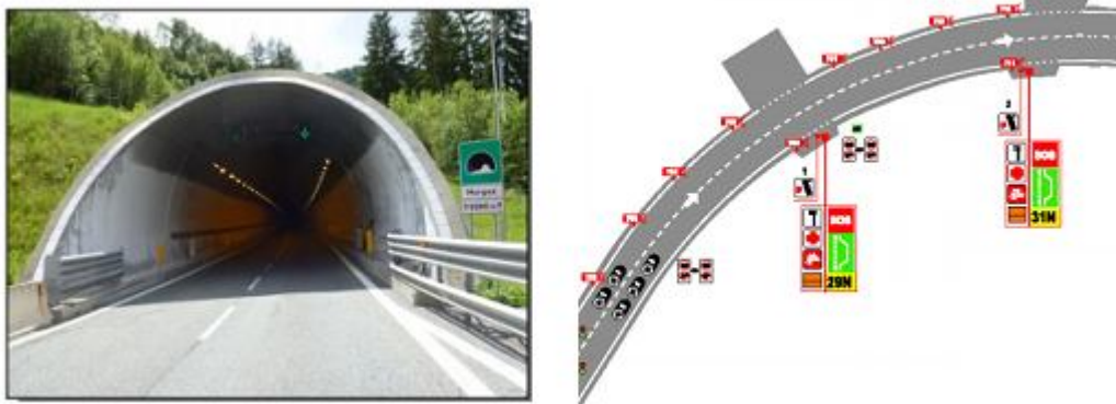
Figura 79: Imbocco della galleria Morgex Nord e rappresentazione schematica di parte del tunnel
