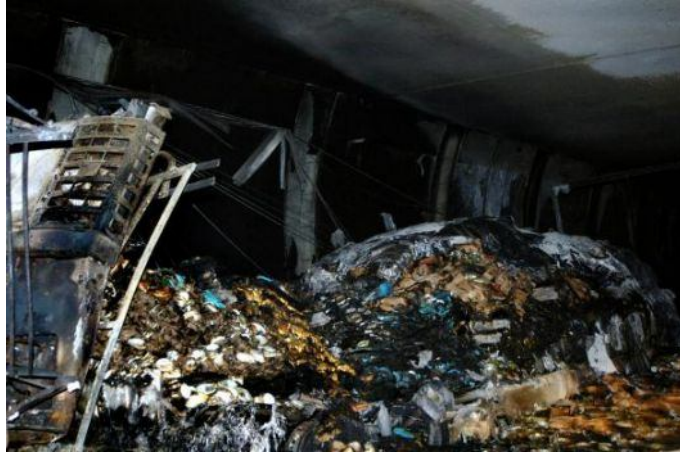
Figura 5: Rogo all'interno del tunnel del Frejus, situazione al termine dell'intervento dei soccorsi
