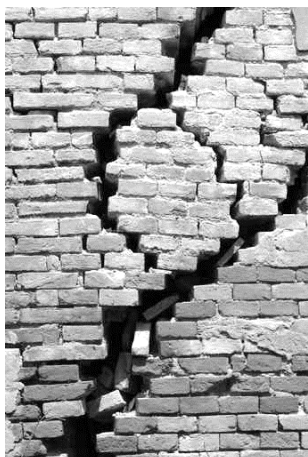
Fig. 84 - Prova di compressione su un paramento murario
