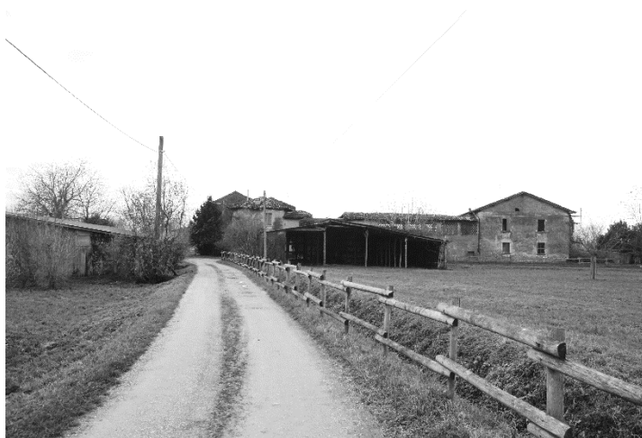
Fig. 128 - Vista della cascina provenendo dalla strada provinciale 69.
