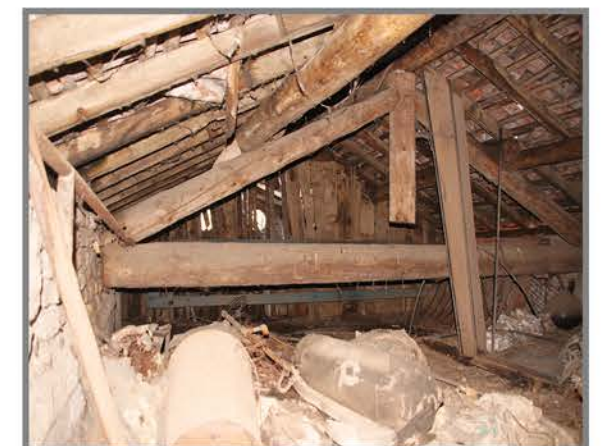
6 - Struttura del tetto
