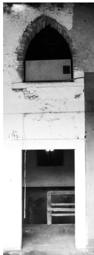
Fig. 135 - Fotografia di uno degli accessi al sottotetto, scattata dal portico del blocco A in corrispondenza del vano scala. Da notare il dettaglio dell'arco ogivale presente solamente in questa sezione.
