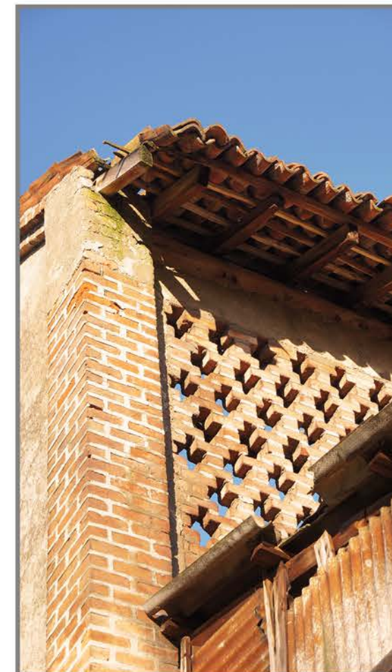
4 - Dettaglio angolo Sud - Ovest
