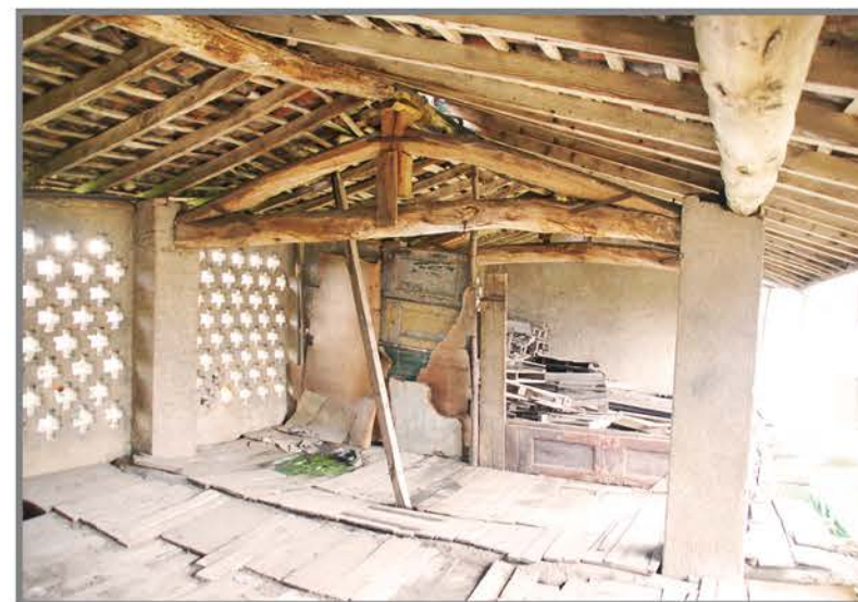
2 - Vista del piano superiore
