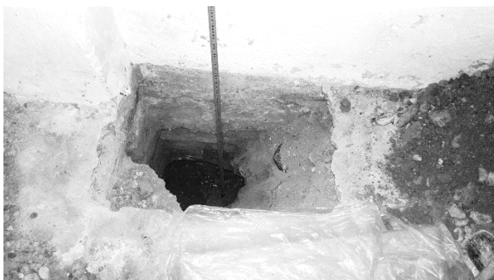
Fig. 153 - Foto dello scavo d'ispezione delle fondazioni in prossimità della nicchia.
