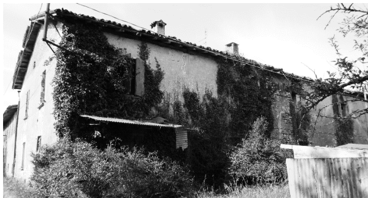
Fig. 131 - Veduta del prospetto settentrionale della cascina.
