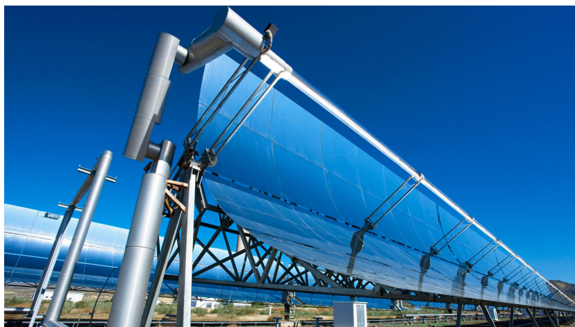
Figura 1.5: Ricevitore parabolico di un impianto CSP
