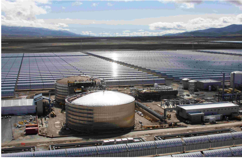
Figura 2.9: Il doppio serbatoio a sali fusi nell'impianto Andasol I
