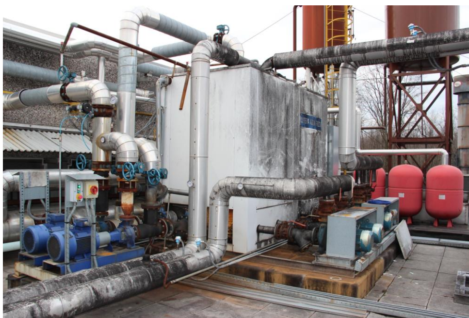
Figura 3.7. Foto della vasca di acqua refrigerata presente sul terrazzo di G2.
