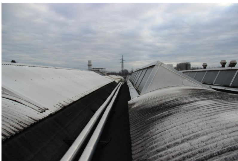
Figura 6.8. Foto scattata sul tetto dell'edificio G2 in cui si nota la conformazione dello stesso favorevole alla posa delle tubazioni.
