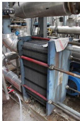
Figura 3.2. Foto dello scambiatore Alfa Laval presente presso l'impianto.
