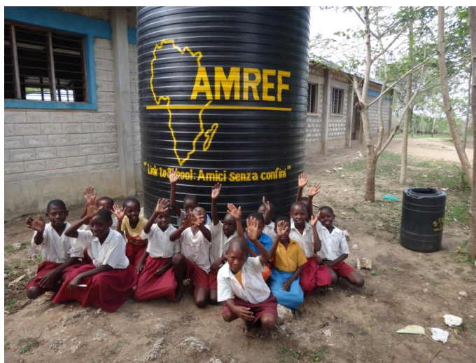
Figura 1.3.2: Cisterna per la raccolta dell'acqua piovana installata in un istituto scolastico
