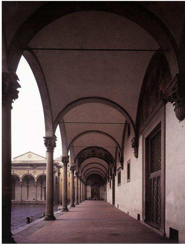
Figura I Catene del porticato dello Spedale degli Innocenti di Filippo Brunelleschi a Firenze.
