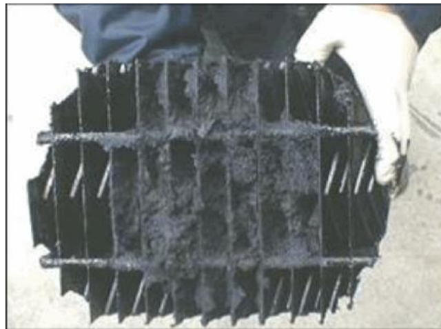
Figura 27: fouling causato dall'accumulo di TAR
