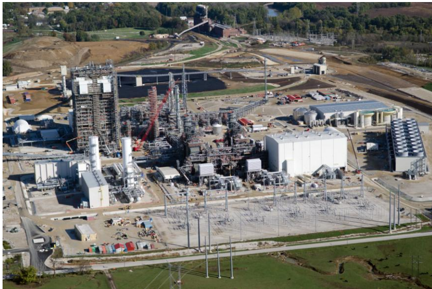
Figura 31: la centrale IGCC della Duke Energy di Edwardsport, Indiana
