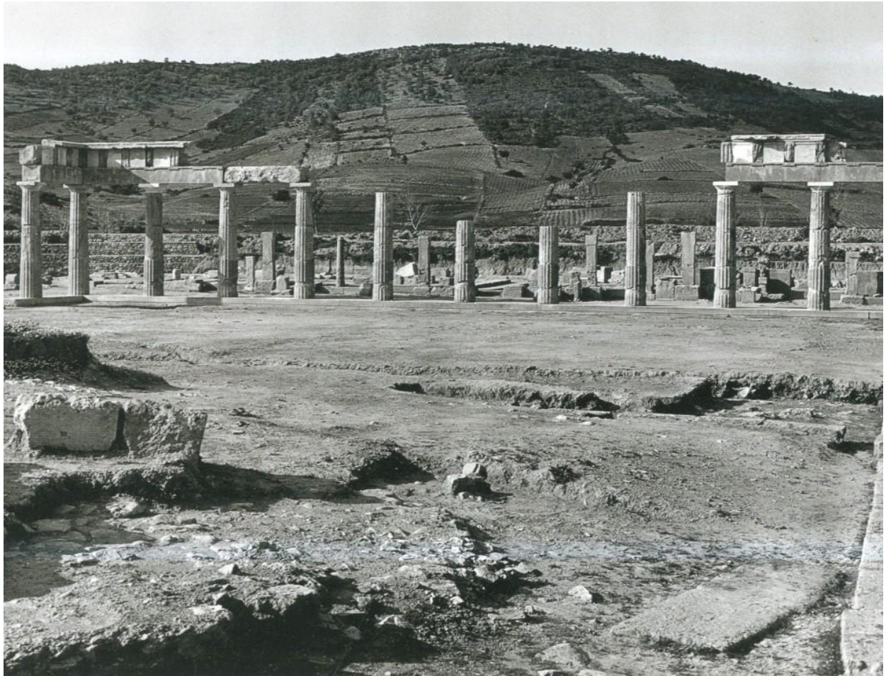
Figura 43. La Stoa di Artemide a Vravrona in seguito all'intervento di anastilosi, fotografia di I. Ioannidou, tratta da Συντήρηση, αναστήλωση και αποκατάσταση μνημείων στην Ελλάδα 1950-2000 , a cura di C. Bouras, P. Tournikiotis, 2010, p. 23
