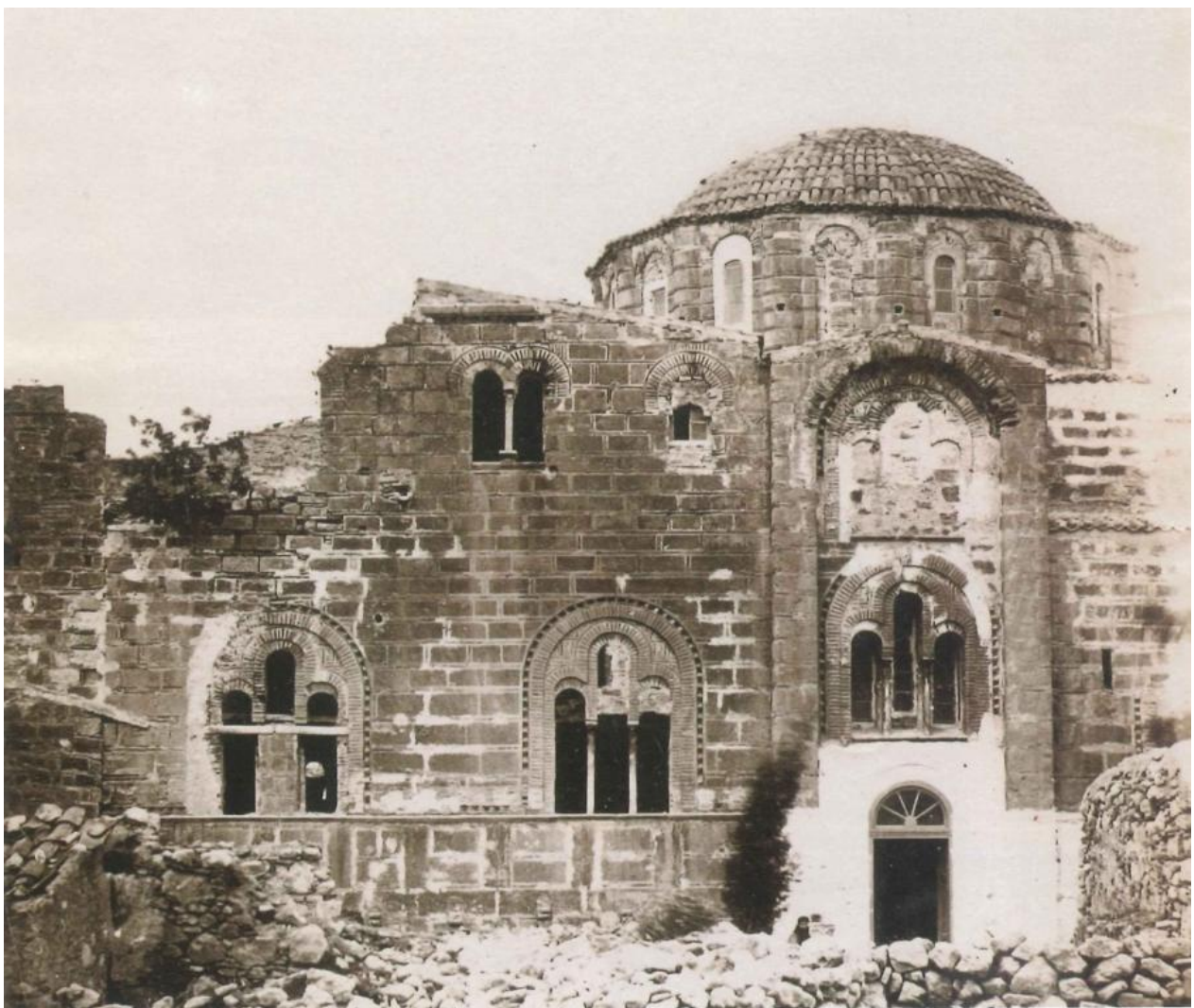
Figura 20. Monastero Dafniou, prospetto sud, prima degli interventi del 1888-89, da E. CHLEPA, Ta Byzantiná mnhmeía στη Neóterh Elláda. Ideología kai praktikh ton apokatastáseon (1833-1939) , 2011, p. 83
