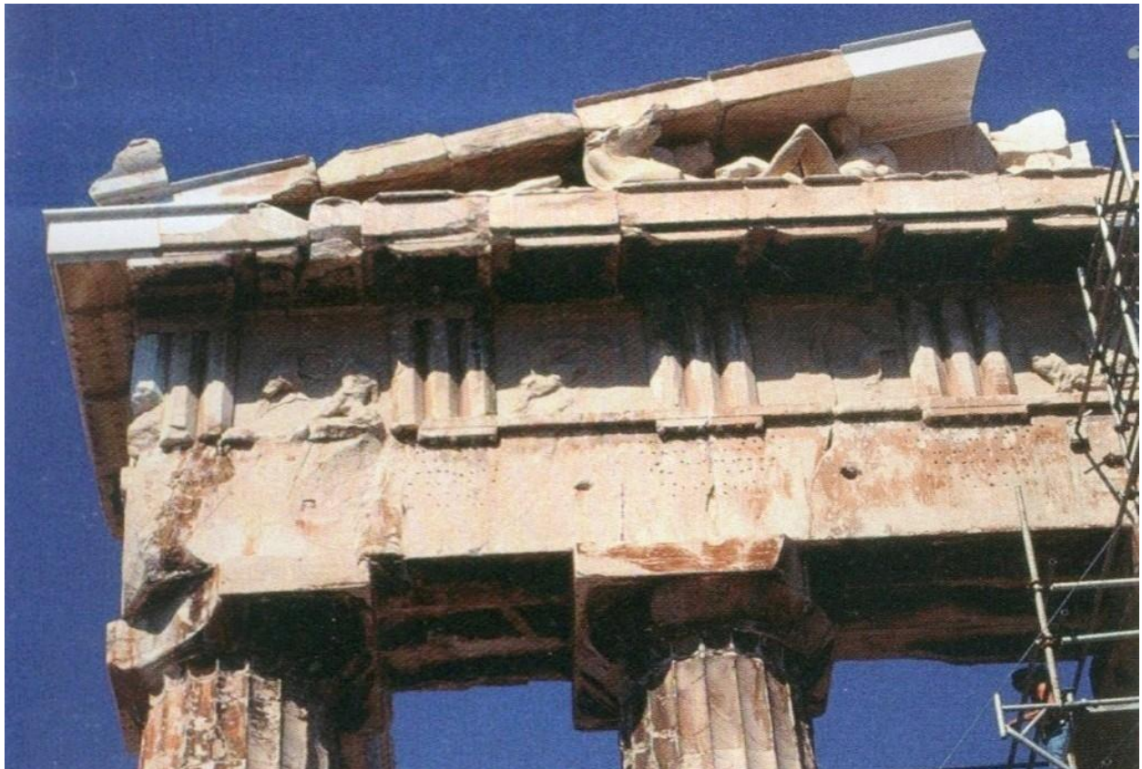
Figura 58. Il lato orientale del Partenone nel 1994, dopo il restauro del geison, fotografia di P. Tournikiotis, da P. Tournikiotis, Ιδεολογικά και θεωρητικά προβλήματα αναστήλωσης αρχιτεκτονικών μνημείων στην Ελλάδα στο δεύτερο μισό του 20ού αιώνα , in Συντήρηση, αναστήλωση και αποκατάσταση μνημείων στην Ελλάδα 1950-2000 , a cura di C. Bouras, P. Tournikiotis, 2010, p. 24
