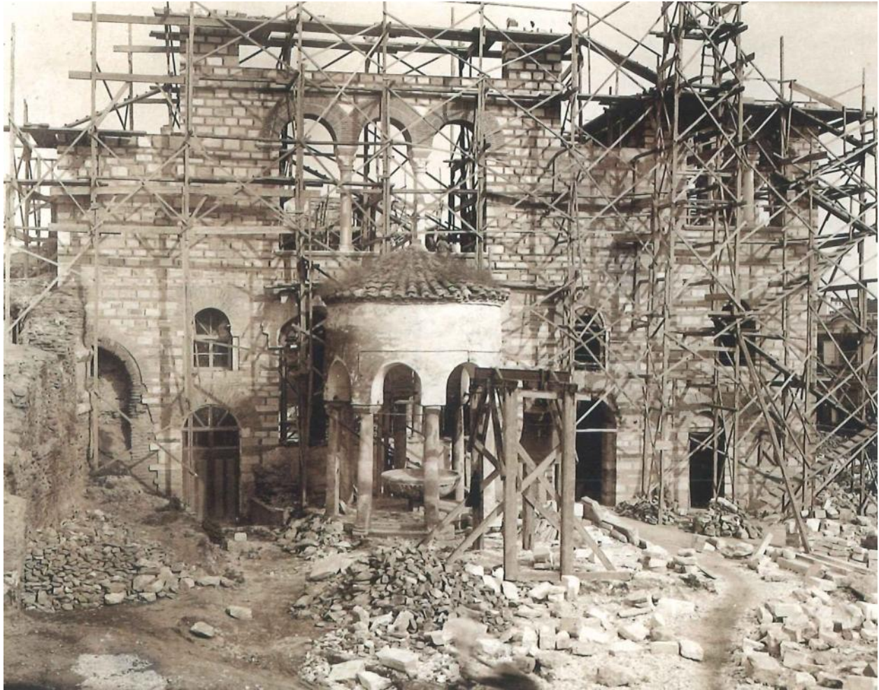
Figura 33. Basilica di San Demetrio. Interventi di restauro del prospetto occidentale, dopo l'abbattimento del minareto (1924) nell'angolo nord ovest della basilica, da E. CHLEPA, Ta Byzantiná mnhmeía sti Neóterh Elláda. Ideología kai praktikh ton apokatastáσεων (1833-1939) , 2011, p. 176
