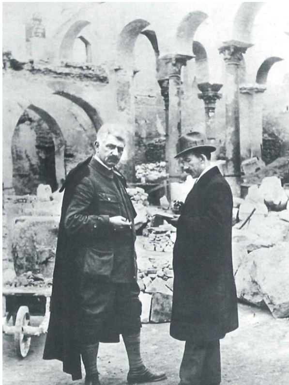
Figura 30. A. Zachos e G. Sotiriou all'interno della Basilica di San Demetrio, durante l'inizio dei lavori (1917)
