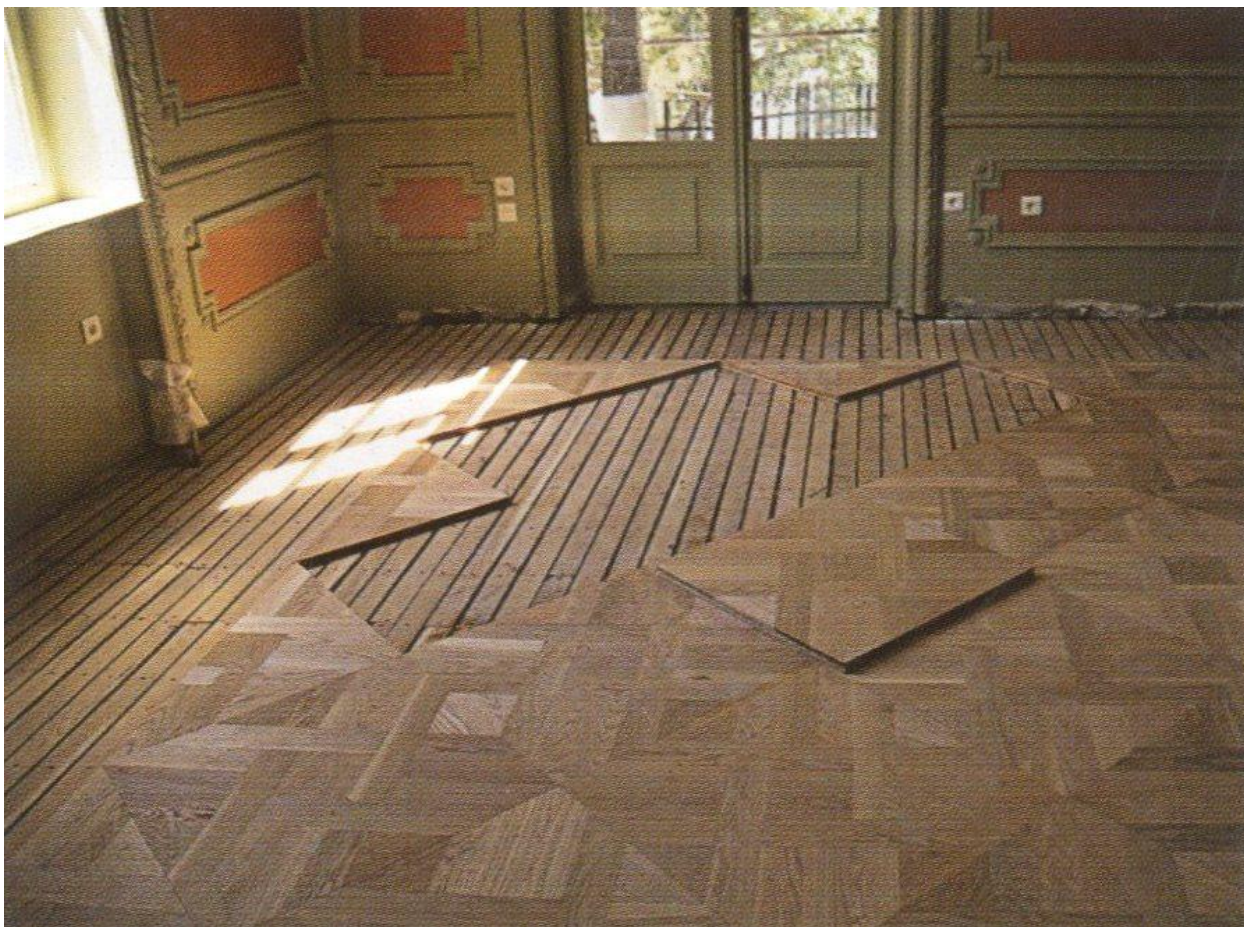
Figura 97. Ricostruzione dei pavimenti lignei secondo motivi decorativi originali ripodotti sulla base delle fotografie d'archivio, da Restoration of Casa Bianca in Thessaloniki. From the study to the Application , a cura di M. Nomikos, 2001, p. 112
