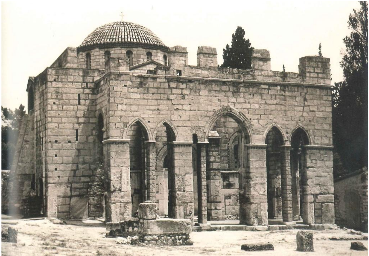
Figura 22. Monastero Dafniou, prospetto occidentale dopo le operazioni di ricostruzione del porticato occidentale da parte dell'architetto Eustratio Stikas nel 1959 (1996), da E. CHLEPA, Ta Byzantiná mnhmeía sti Neóterh Elláda. Ideología kai praktikh ton apokatastáσεων (1833-1939) , 2011, p. 99
