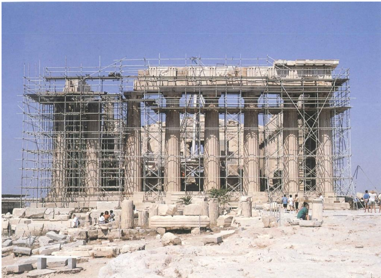
Figura 54. Gli interventi del Comitato per la Conservazione dei monumenti dell'Acropoli: il fronte est nel momento di massimo smantellamento durante le operazioni di anastilosi, da The Parthenon And Its Impact in Modern Times , a cura di P. Tournikiotis, 1994, p. 332
