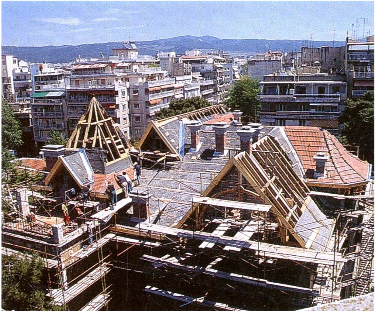
Figura 95. Immagine del cantiere durante la fase di ricostruzione del tetto dell'edificio, da Restoration of Casa Bianca in Thessaloniki. From the study to the Application , a cura di M. Nomikos, 2001, p. 110
