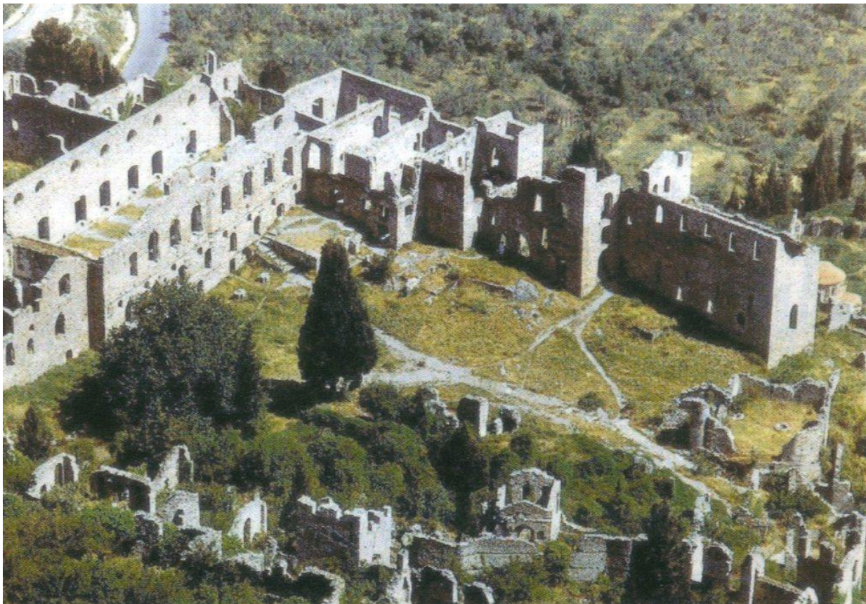
Figura 69. Vista dall'alto del Palazzo di Mistras prima dell'inizio dei lavori del Comitato per la Conservazione dei Monumenti di Mistras. in Restoration of Monuments - Rehabilitation of Historical Buildings in Peloponnesus , a cura di N. Charkiolakis, 2008, p. 125
