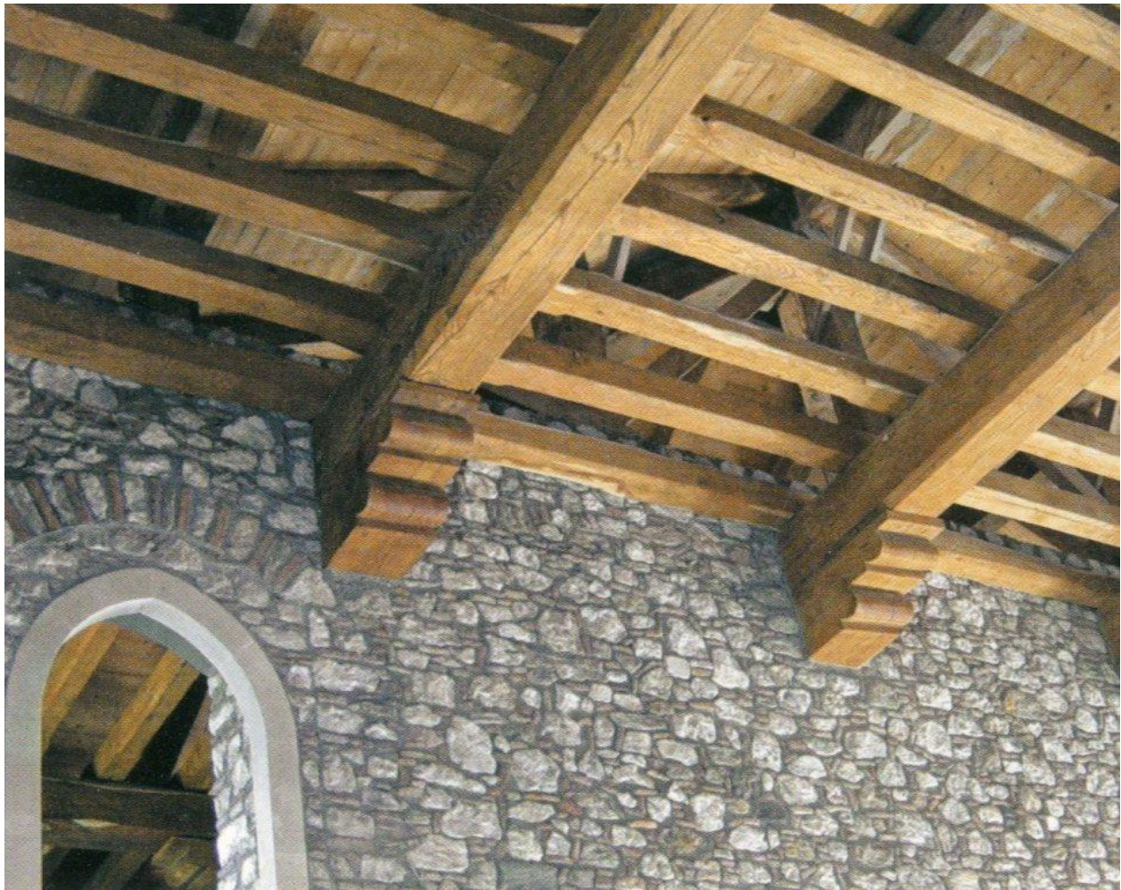
Figura 73. Dettaglio della copertura dell'edificio di Manuel Kantakouzinis, in Restoration of Monuments - Rehabilitation of Historical Buildings in Peloponnesus , a cura di N. Charkiolakis, 2008, p. 128
