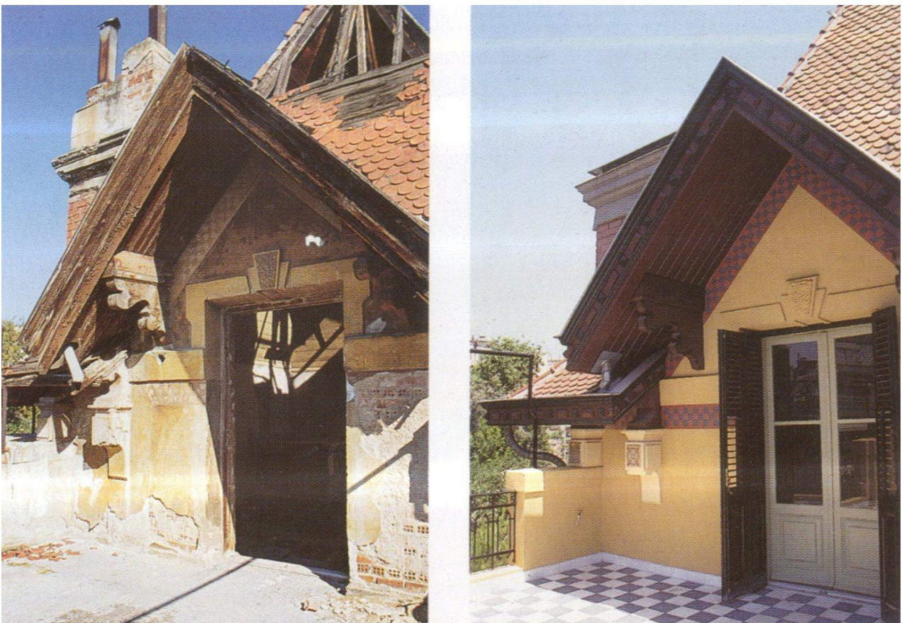
Figura 96. Immagine dell'apertura sulla terrazza prima e dopo gli interventi, da Restoration of Casa Bianca in Thessaloniki. From the study to the Application , a cura di M. Nomikos, 2001, p. 114
