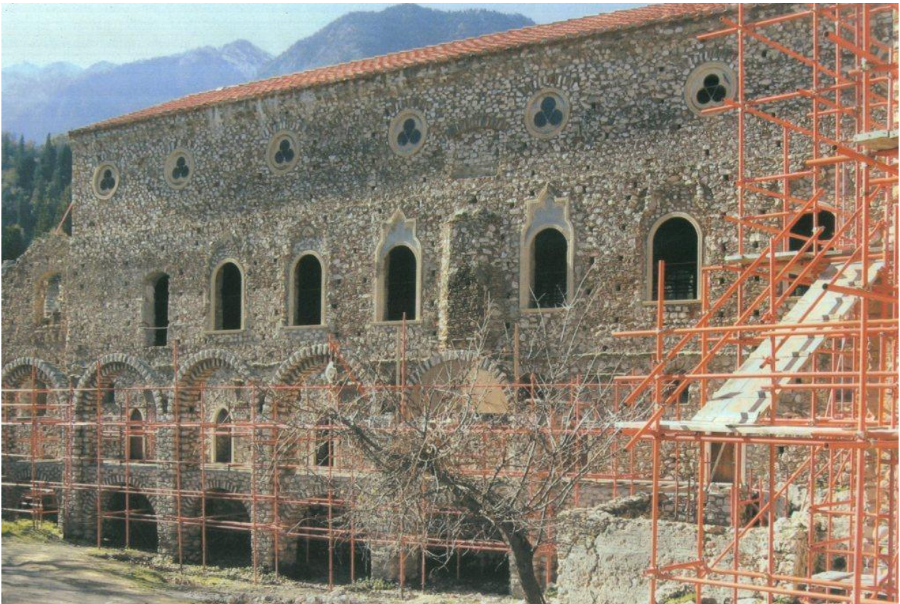
Figura 76. Fronte sud della Sala del Trono, dopo la ricostruzione del loggiato, in Restoration of Monuments - Rehabilitation of Historical Buildings in Peloponnesus , a cura di N. Charkiolakis, 2008, p. 139
