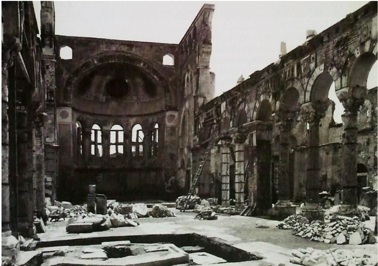
Figura 32. Basilica di San Demetrio, vista interna dopo gli interventi di salvaguardia strutturale del periodo 1917-1918, fotografia F. Boissonais, 1919, tratta da D. ZYGOMALAS, Η προστασία των αρχιτεκτονικών μνημείων του βορειοελλαδικού χώρου από την οθωμανική κατάκτηση έως τον Β' Παγκόσμιο Πόλεμο (1361 1939) , tesi di dottorato, Salonicco 2013, p. 402
