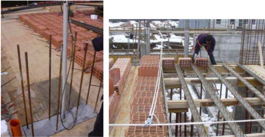
Fig. 5.3: Esempio di posa in opera solaio con travetti prefabbricati
