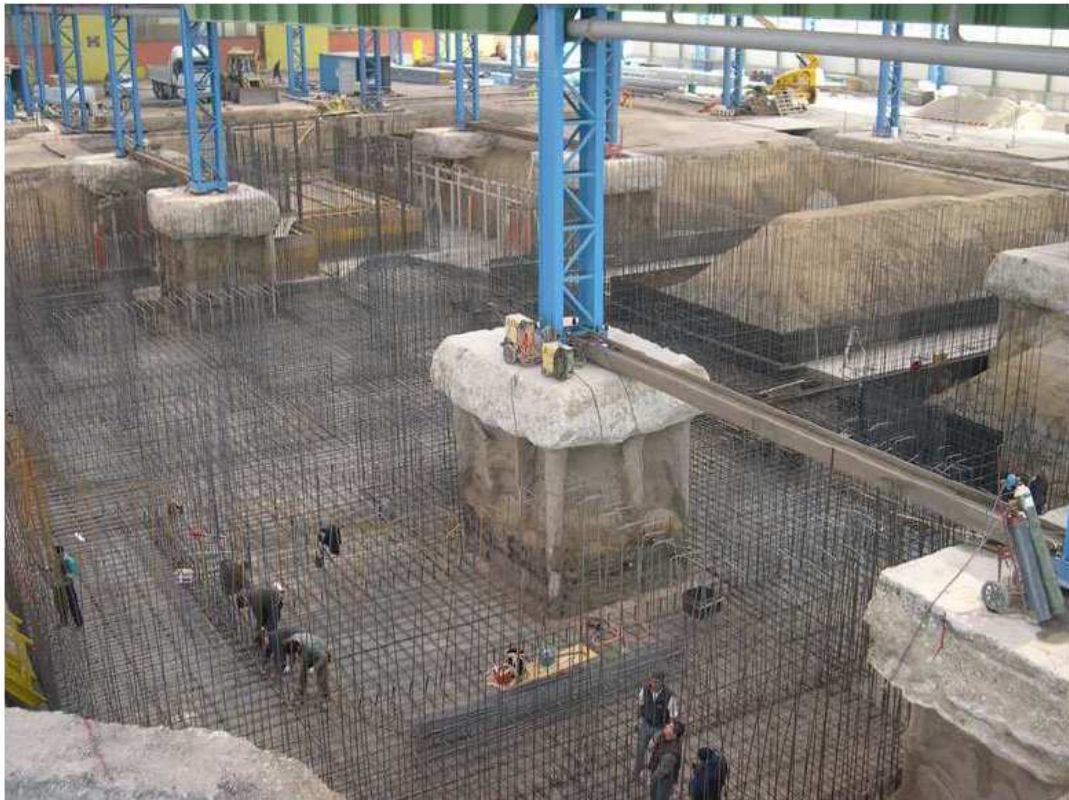
Fig. 4.6: Esempio di fondazione profonda
