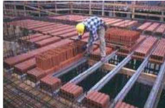
Fig. 5.2: Realizzazione banchinaggio e posa in opera pignatte senza protezioni
