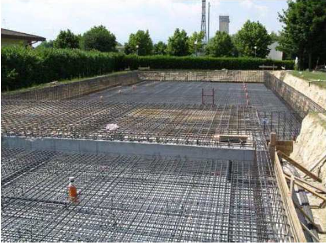
Fig. 4.8: Armature di una platea di fondazione
