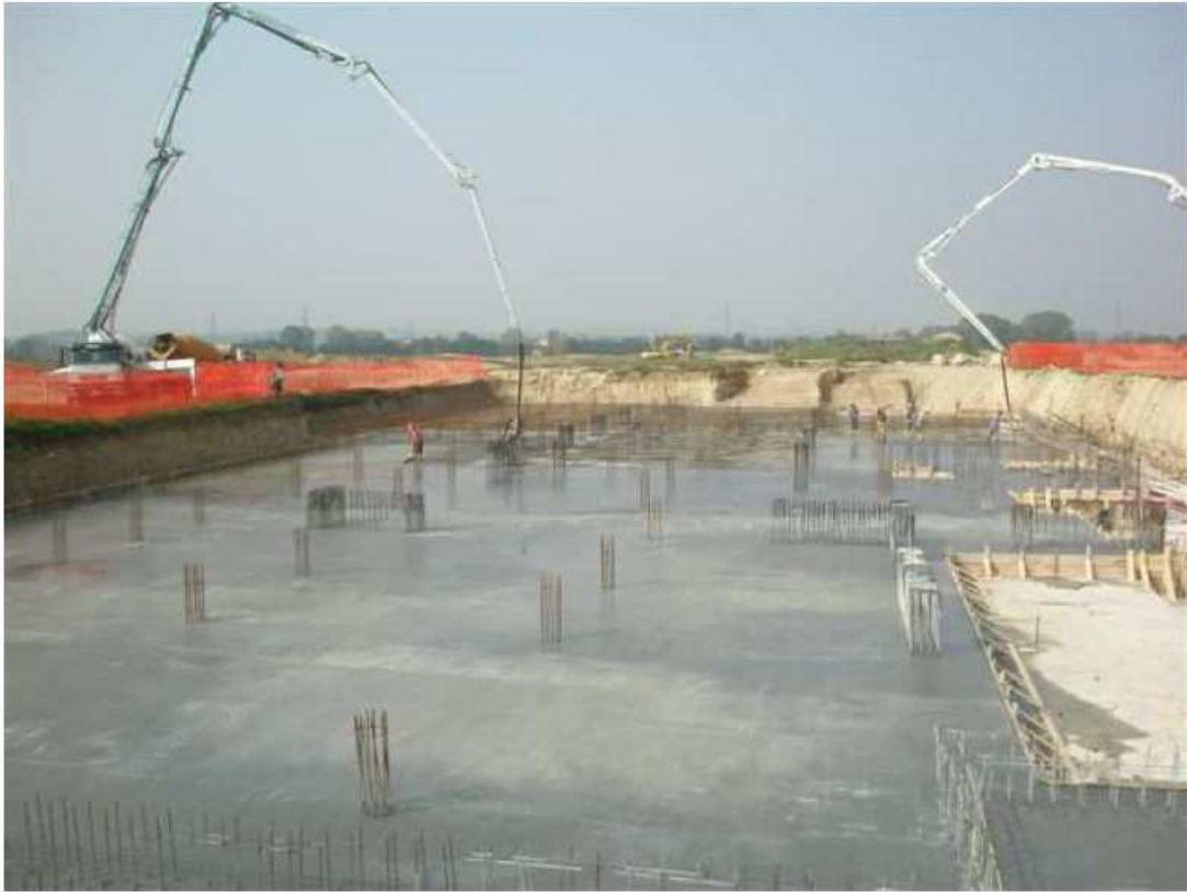
Fig. 4.7: Esempio di getto di platea di fondazione
