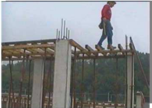
Fig. 5.2: Realizzazione banchinaggio e posa in opera pignatte senza protezioni
