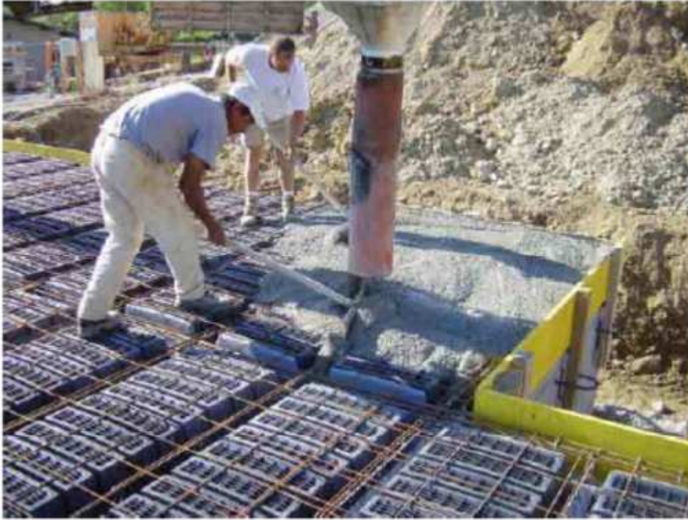
Fig. 5.1: Posa in opera solaio con interblocchi in neopropilene
