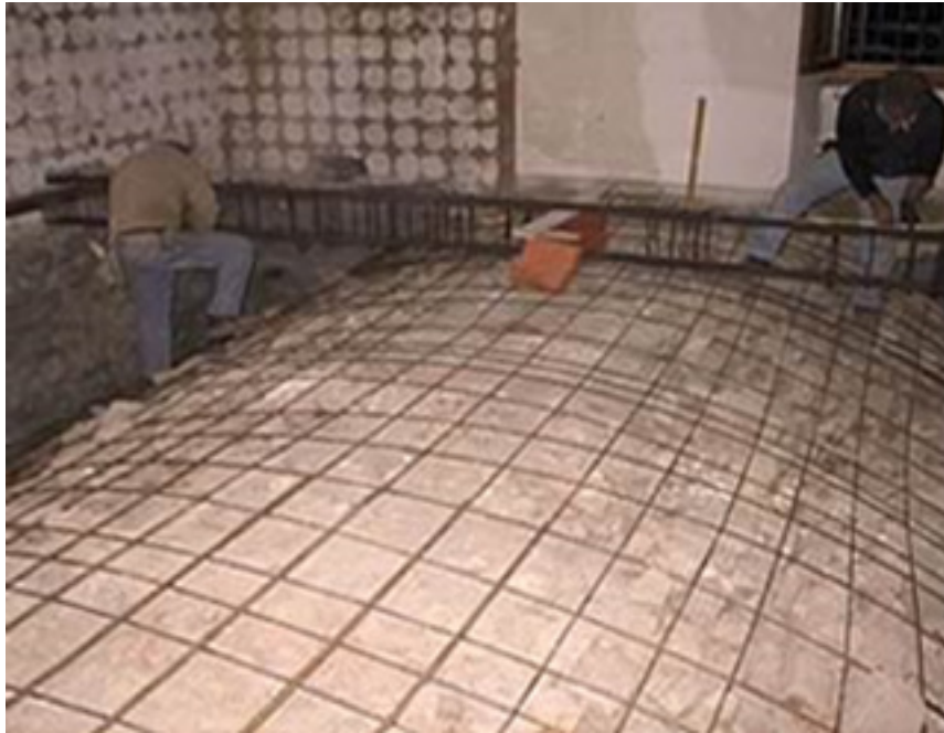
Figura n°24: Volta con Cappa armata.
