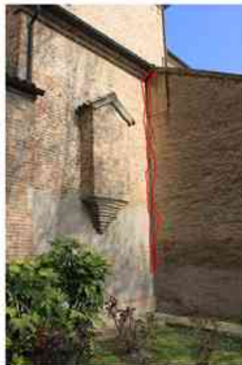
RIBALTAMENTO DELLA PARETE ATERALE DESTRA
