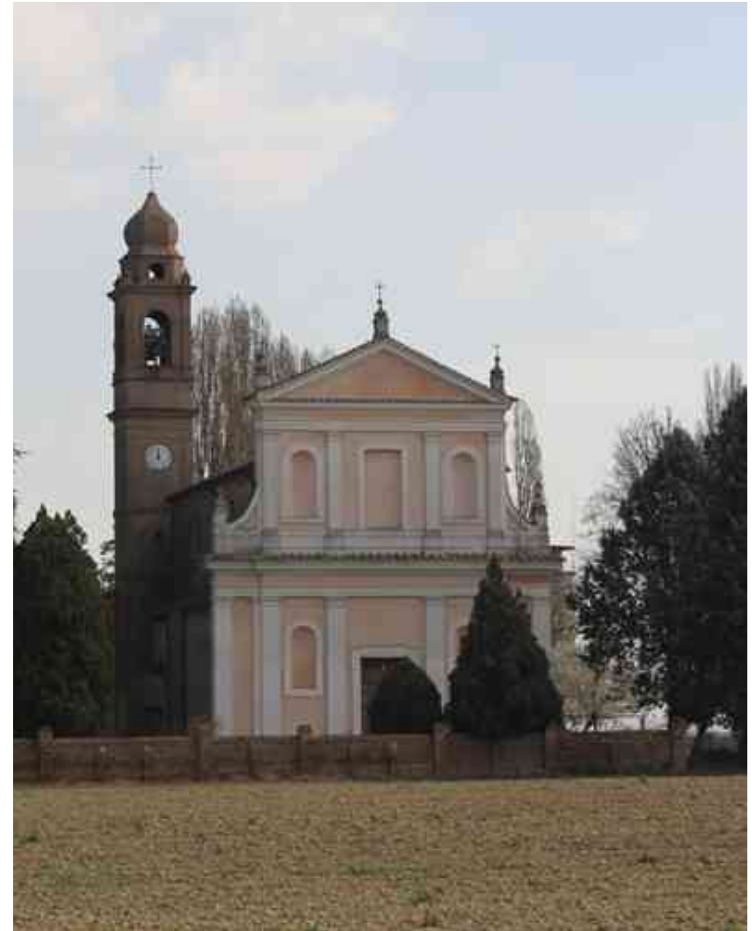
Figura n°75: Chiesa della Conversione di San Paolo dopo il terremoto del 2012.
