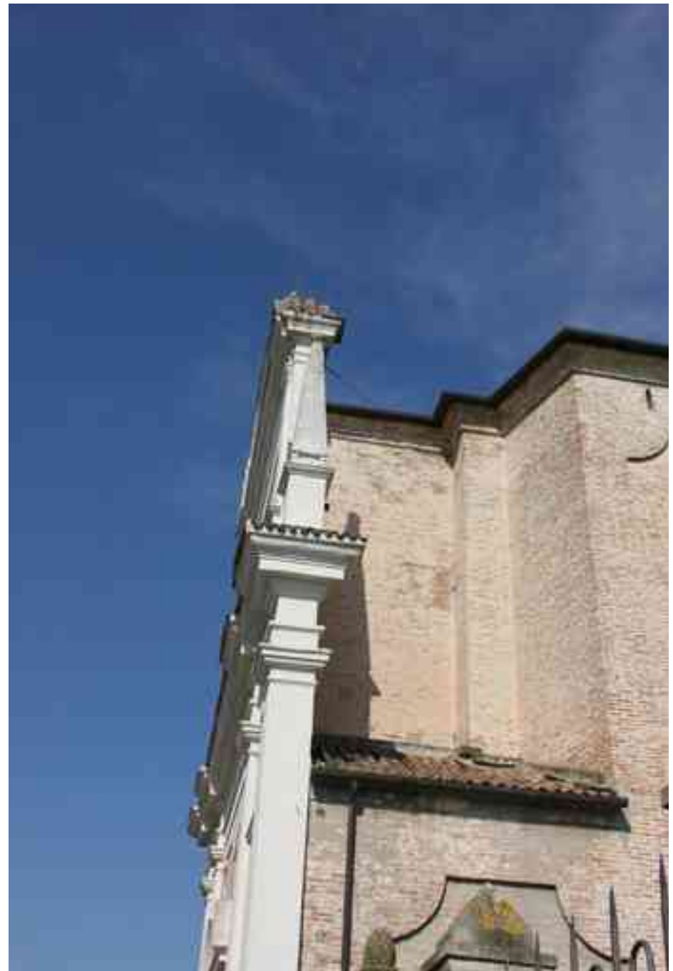
Figura n°74: Opera di messa in sicurezza della facciata.
