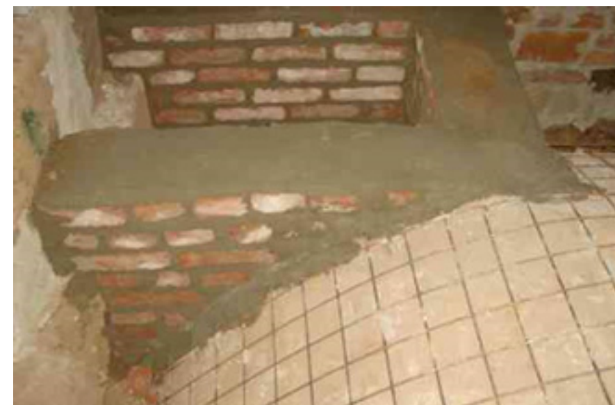
Figura n°23: Volta con frenelli.
