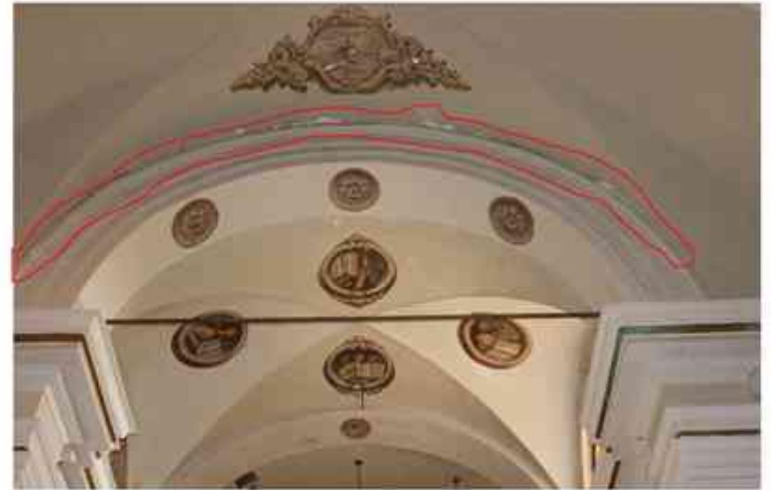
MECCANISMO DI COLLASSO DELL'ARCO TRIONFRALE
