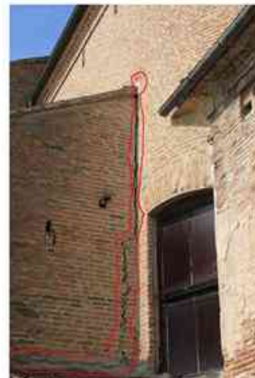
RIBALTAMENTO DELLA PARETE ATERALE DESTRA
