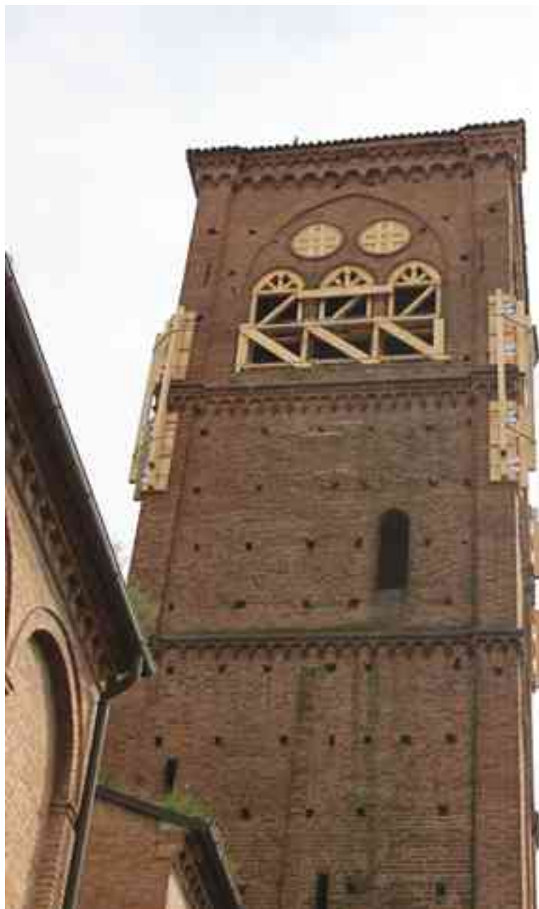
Figura n°65:Opera di messa in sicurezza per il campanile.
