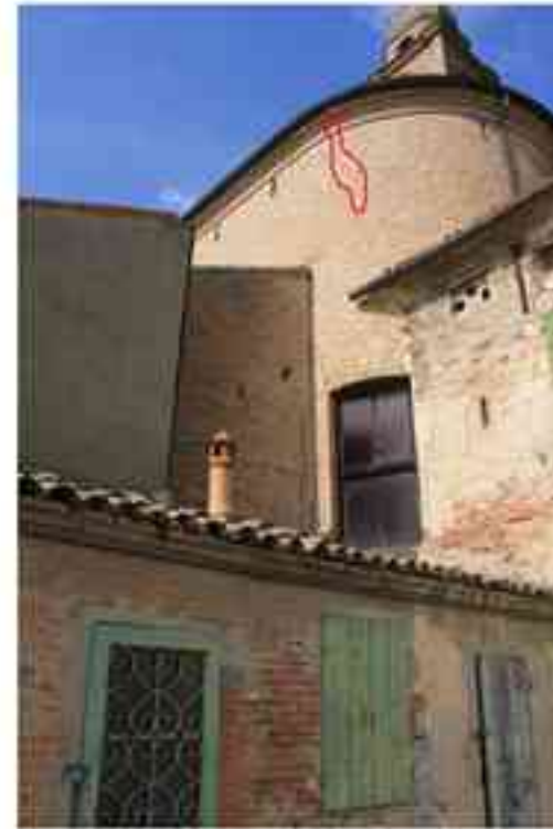
RIBALTAMENTO DELLA PARETE ATERALE DESTRA
