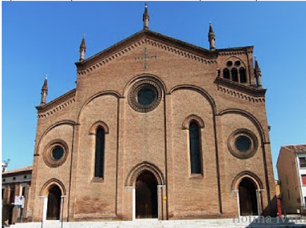
Figura n°63: Facciata della chiesa di Bondeno prima del terremoto del 2012.
