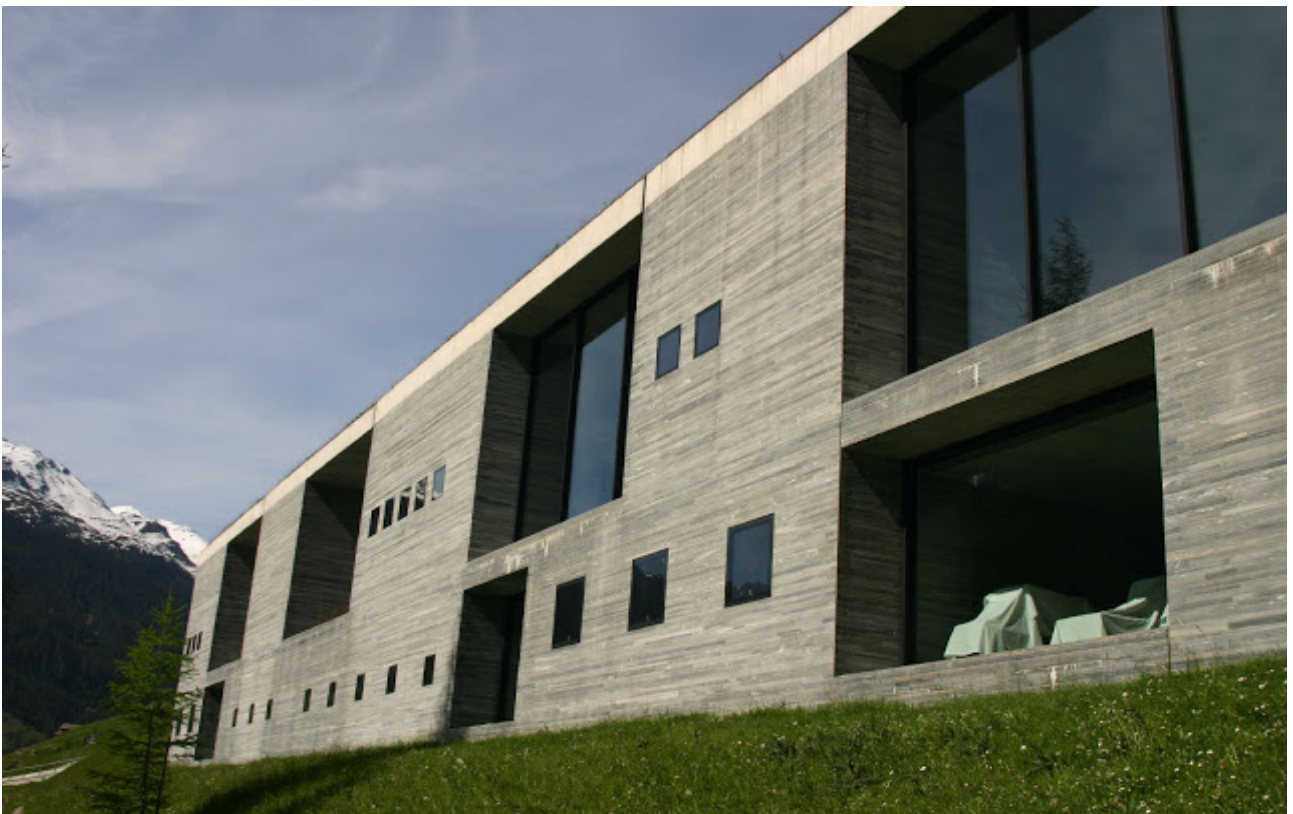
Fig. 39 Vista interna delle vasche e prospetto esterno. Dietmar Steiner. Bagni termali, Svizzera. Fotografie Margherita Spilluttini. pp. 27-31
