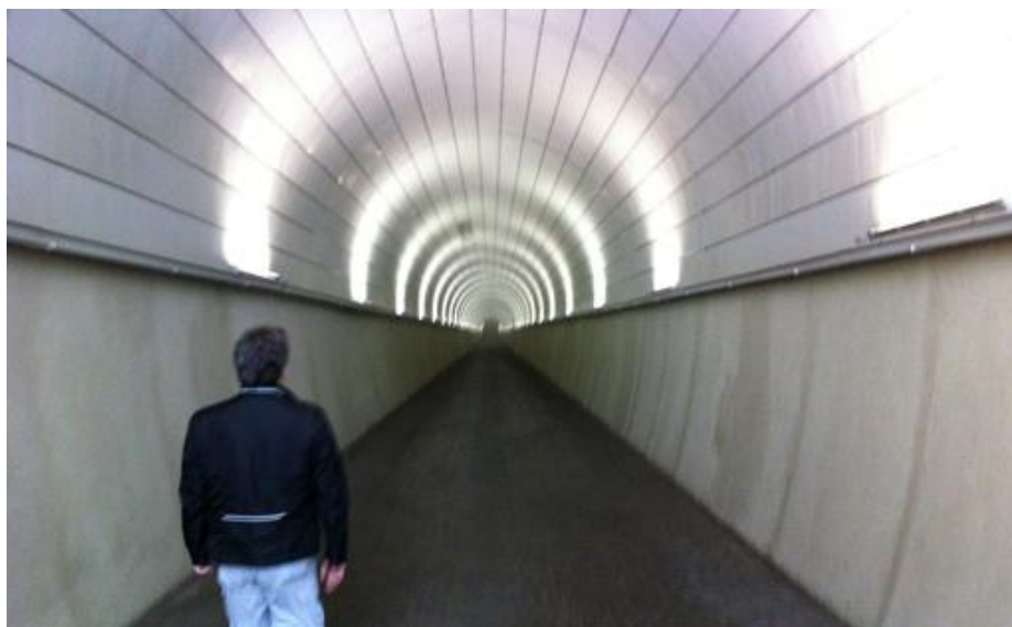
Tunnel tra diga di S. Giustina e turbine
