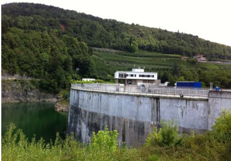
Diga di Santa Giustina e residenza del custode, progettata dall'architetto Giò Ponti
