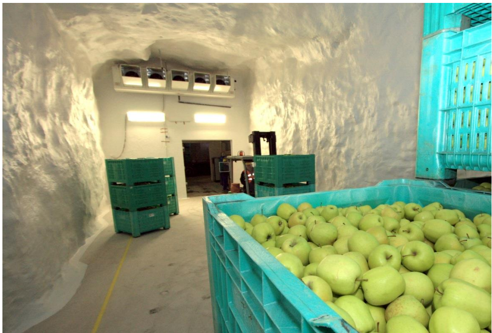
Fotografia di una cella frigo-conservativa (cella prototipo)
