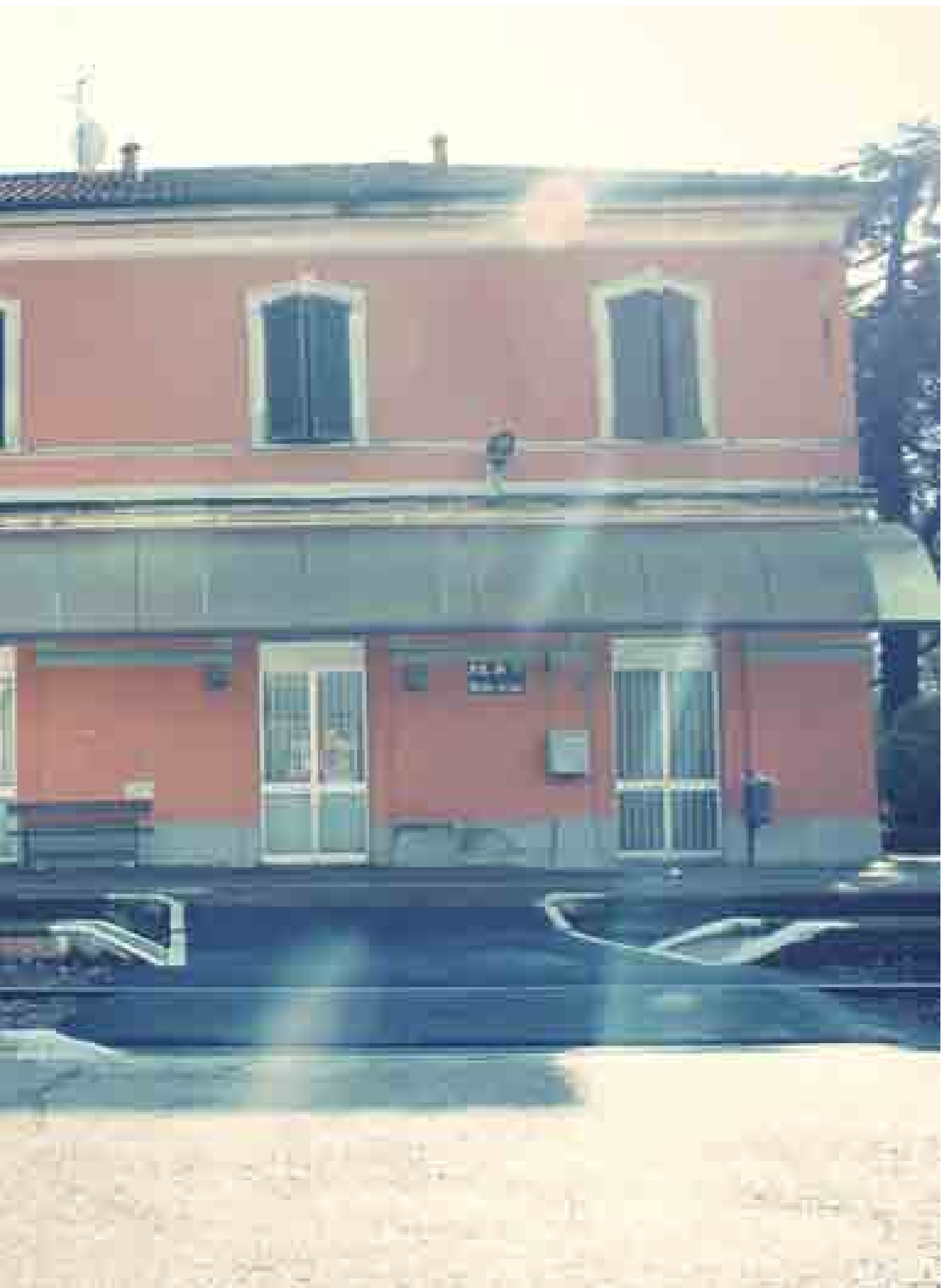
59. Stazione di Oggiono fabbricato passeggeri, "VIETATO ATTRAVERSARE I BINARI" 09/02/2014
