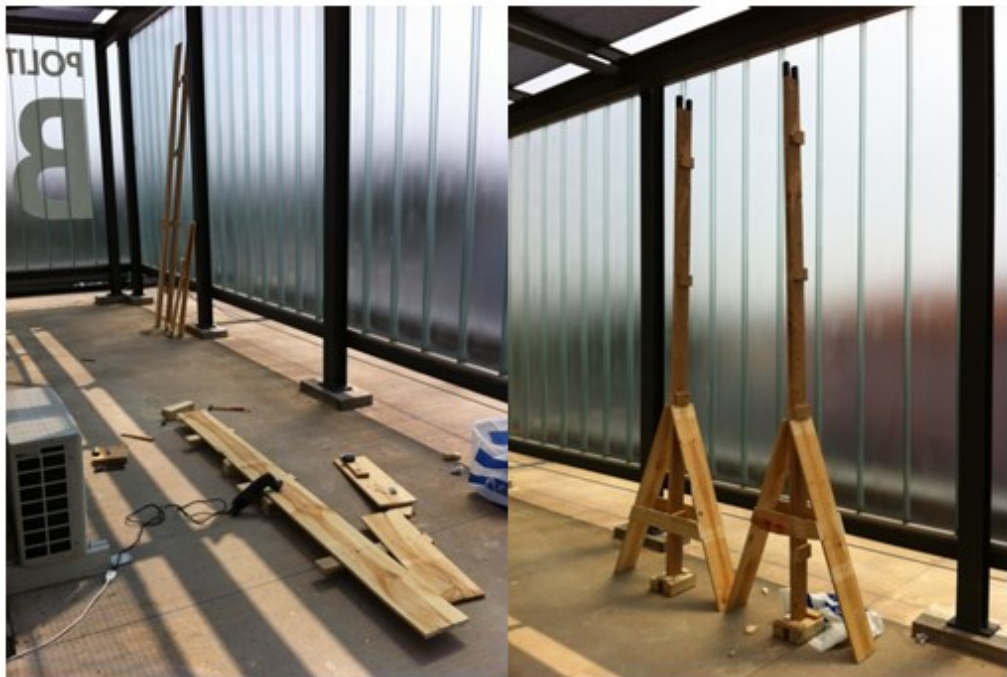
Figura 22. Inizio e completamento struttura per ombreggiamento
