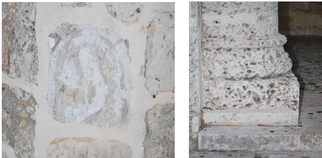
20 e 21 _ Particolari di facciata dell'Alcazar de Colon.
