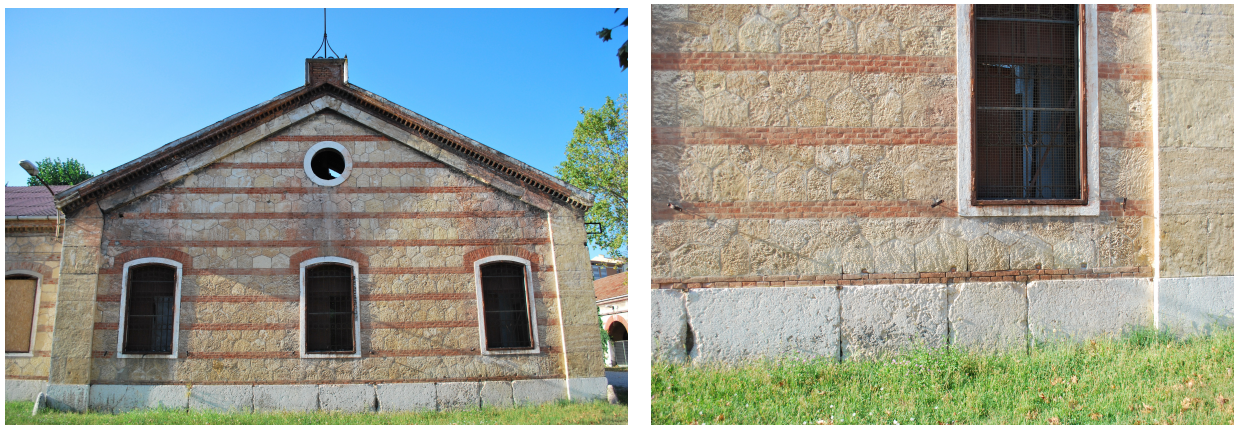
16 e 17 _ Vista della facciata sud dell'edificio e particolare di facciata
