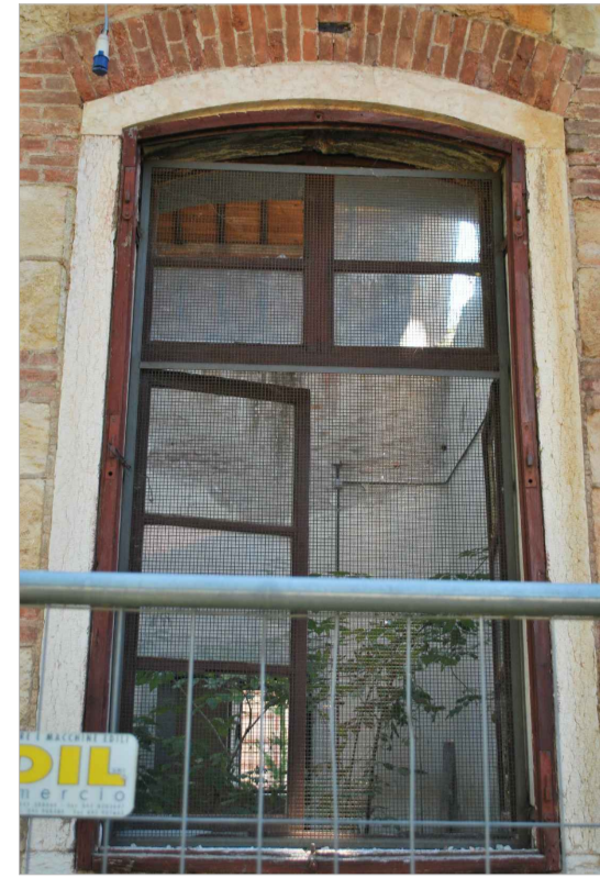
Foto 2. Vista degli interni non accessibili
