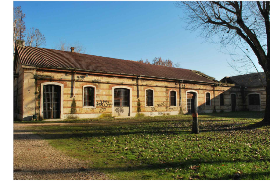
Foto 5. Vista della facciata ovest dell'edificio oggetto del rilievo
