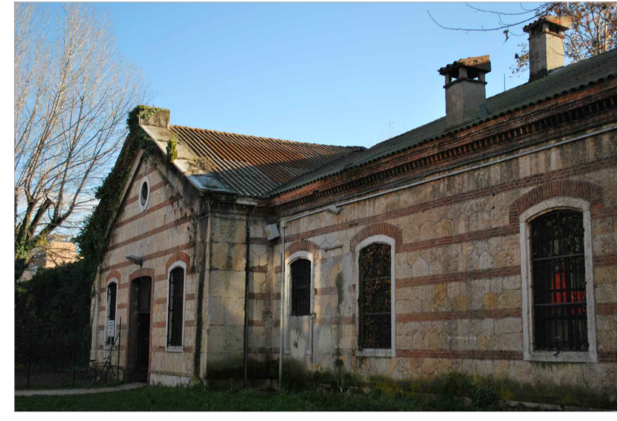
Foto 3- Vista degli edifici dal cortile interno
