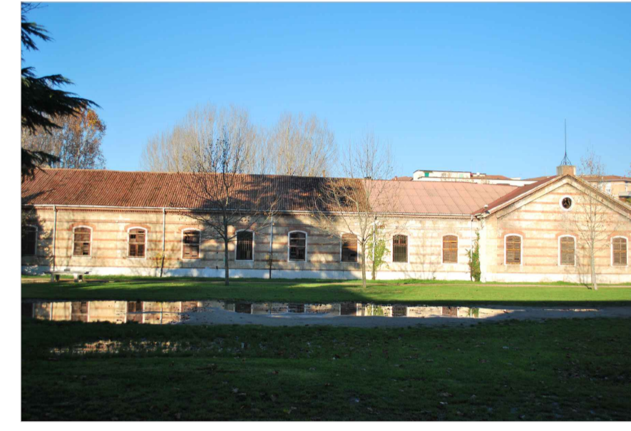
Foto 4. Vista degli edifici dal cortile interno
