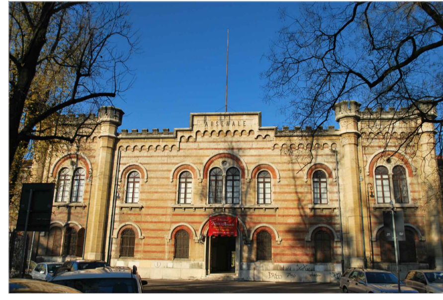
Foto 1. Vista dell'ingresso principale
