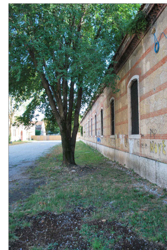
Vista della facciata Est dell'edificio
