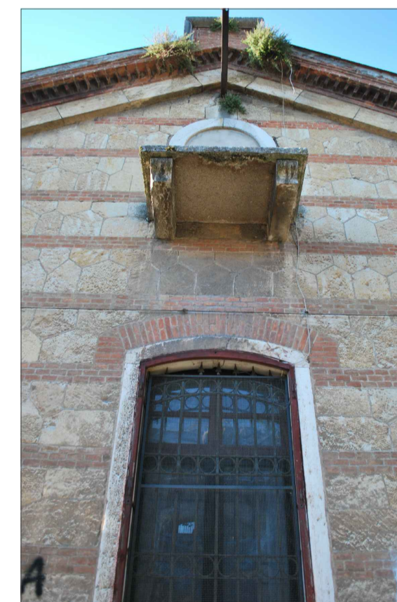
Particolare della facciata Nord
