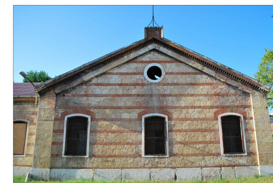
Vista del fronte Sud dell'edificio
