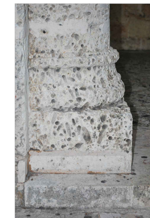
Particolare di una colonna del portico di ingresso
