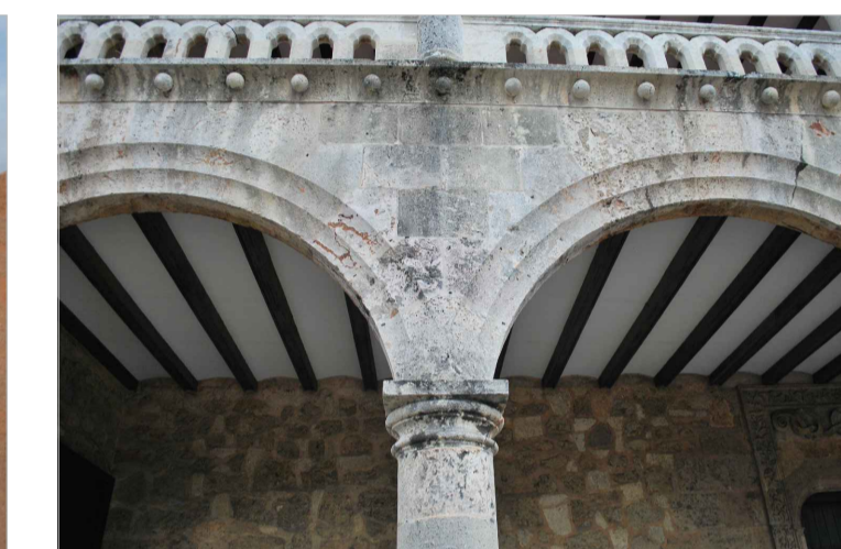
Particolare del portico di ingresso.
