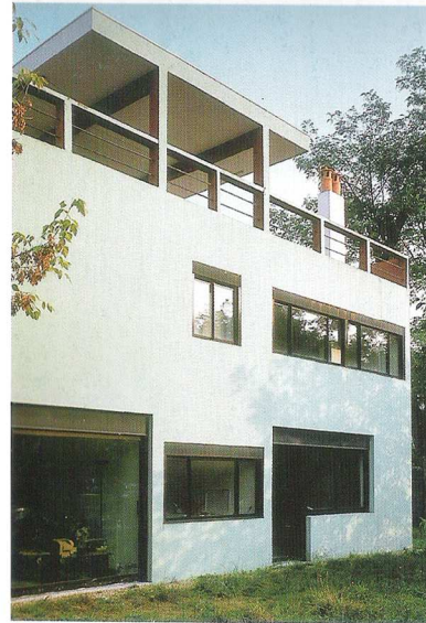
Figg. 4.86. - 4.87. Il ripristino dello stato "originale".
