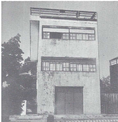
Fig. 4.72. Se si eccettua il cornicione, la facciata ha conservato lo stato originale.
