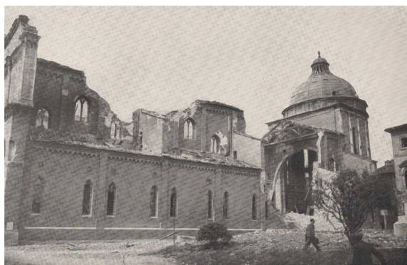
Fig. 4.137. Vicenza, Duomo, l'esterno dopo i danni.
