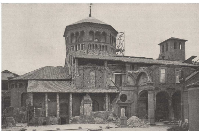
Fig. 4.127. Sant' Ambrogio, l'abside e il portico del Bramante dopo i primi lavori.
