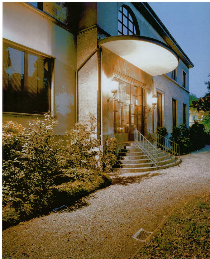
Fig. 4.5. Una veduta notturna della casa, prima dei lavori di restauro del FAI.
