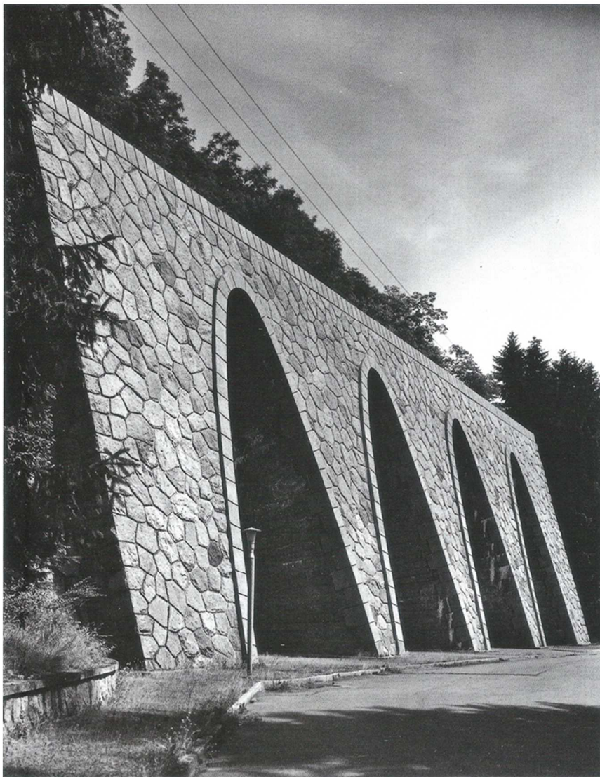
Fig. 3.86. Gabriele Basilico, Ingresso monumentale della centrale idroelettrica Aem di Lovero, 1984.
