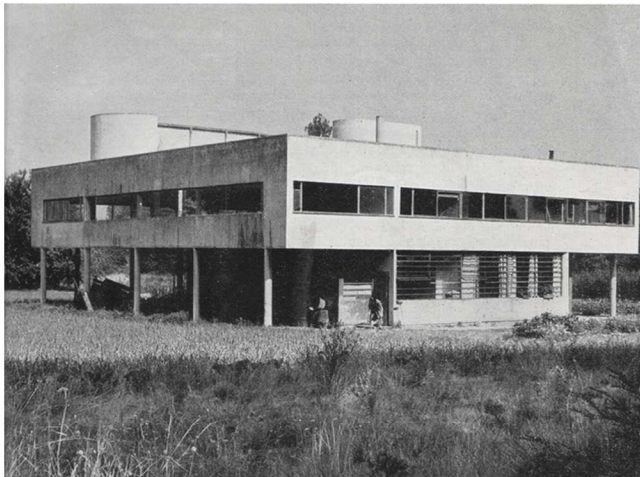
Fig. 3.45. Fotografia tratta dal testo di Benevolo in cui risalta l'avanzato stato di de-grado dell'edificio (Villa Savoye, Le Corbusier, Poissy, 1929-31; foto del 1960 ca. di Leonardo Benevolo. Tratto da L. BENEVOLO, Storia dell'architettura moderna, Laterza, Bari, 1964, p. 673).
