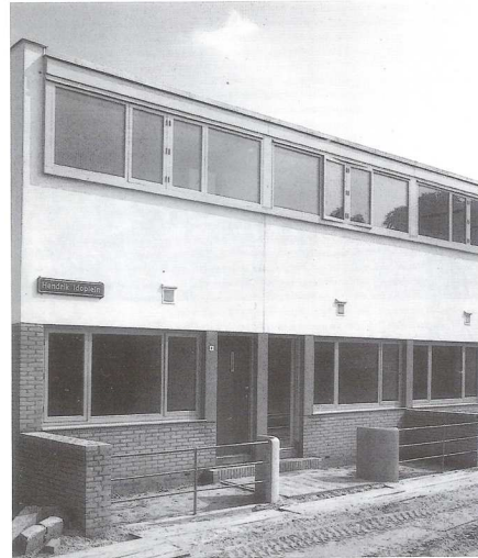
Fig. 4.55. Il nuovo blocco di Hendrik Idoplein.
