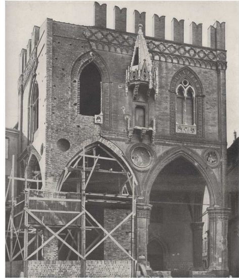
Fig. 4.129. Bologna, Palazzo della Mercanzia durante i lavori di restauro.
