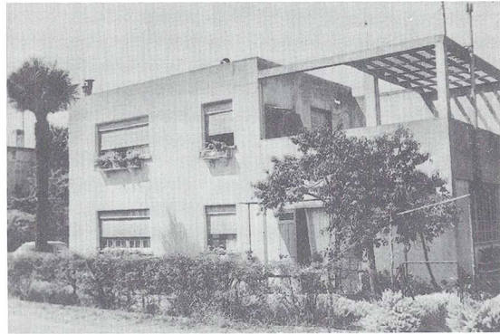
Fig. 4.64. Riduzione della "finestra a nastro" e riempimento dei pilotis.
