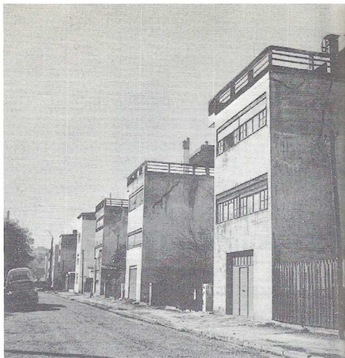
Fig. 4.74. Rue Le Corbusier, sopraelevate d'un piano, le stesse cellule addossate, formano case gemelle.
