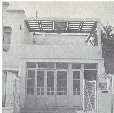
Fig. 4.66. La cantina prevista al piano terra è stata trasformata in garage.
