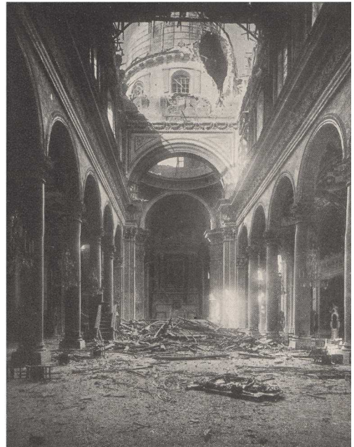
Fig. 4.131. Napoli, Chiesa di San Filippo Neri, l'interno dopo i danni.
