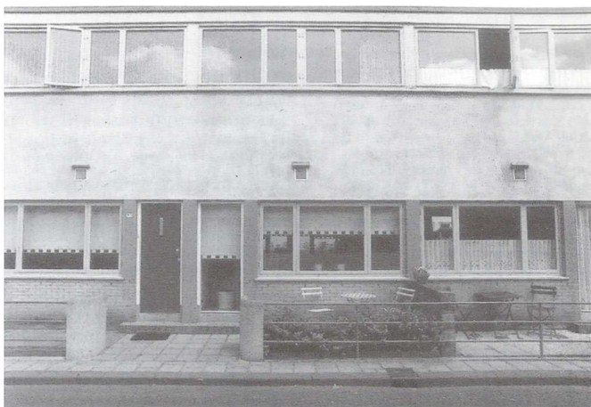
Fig. 4.58. La facciata del nuovo De Kiefhoek: si noti la porta sostituita da un vetro nella tipologia a cinque stanze.
