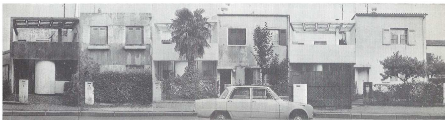
Fig. 4.69. In questa schiera nessuna "finestra a nastro" si è salvata, se ne vede chiaramente la traccia nella seconda casa a sinistra.
