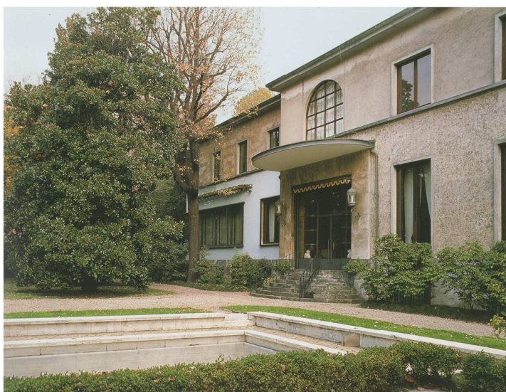
Fig. 4.2. Villa Necchi Campiglio prima dei lavori di restauro del FAI.
