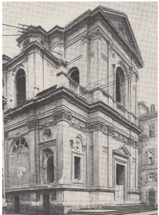
Fig. 4.142. Torino, Chiesa del Carmine, la facciata consolidata.
