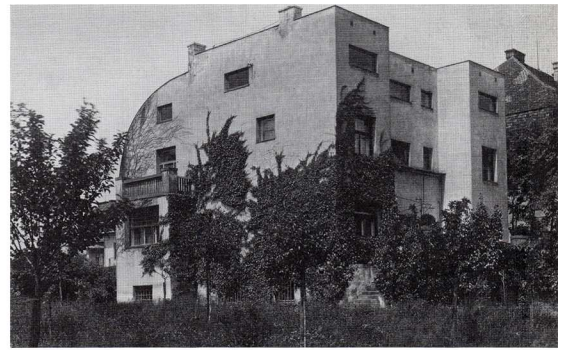
Fig. 4.28. Villa Steiner, facciata sul giardino, 1930.
