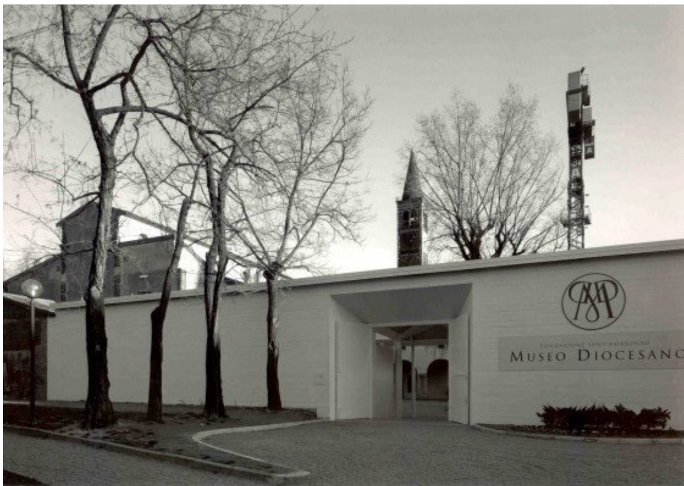
27. Chiusura provvisoria del quarto lato con accesso al secondo chiostro
