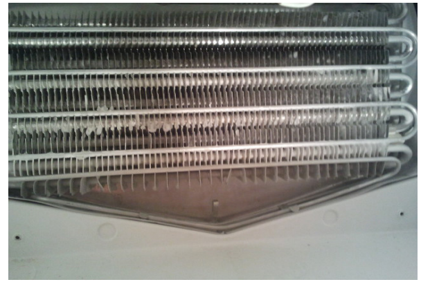
Fig.21 - Depositi di ghiaccio su evaporatore
