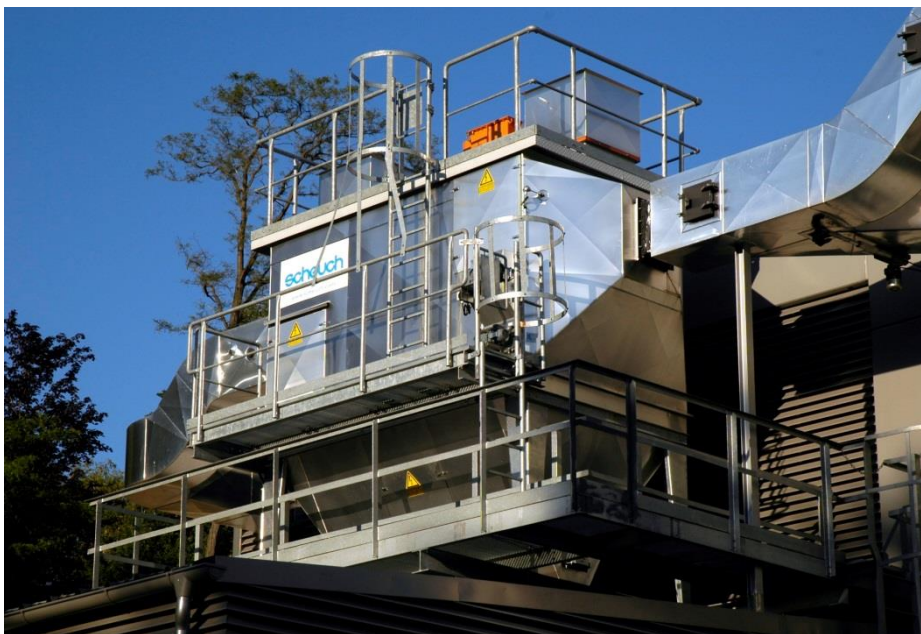
Figura 1.05 - Precipitatore elettrostatico installato su una centrale termoelettrica.
