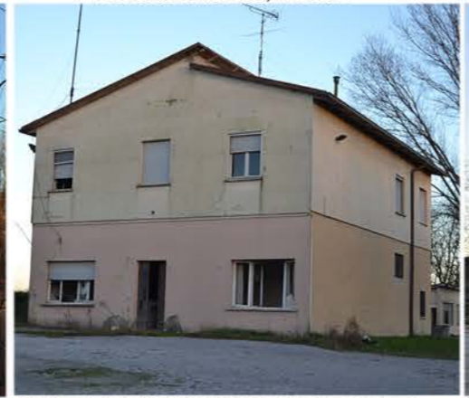
FOTO 14: IMPIANTO DI BETONAGGIO, ABITAZIONE
