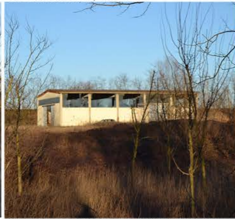
FOTO 13: IMPIANTO DI BETONAGGIO, CAPANNONE
