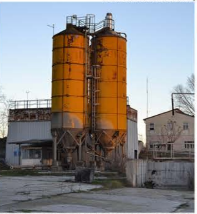
FOTO 15: IMPIANTO DI BETONAGGIO, SERBATOI
