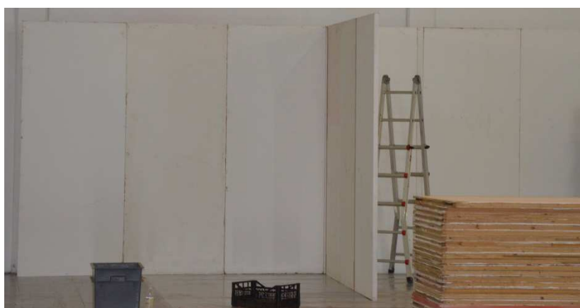
Figura 4-8: Disposizione a T pannelli
