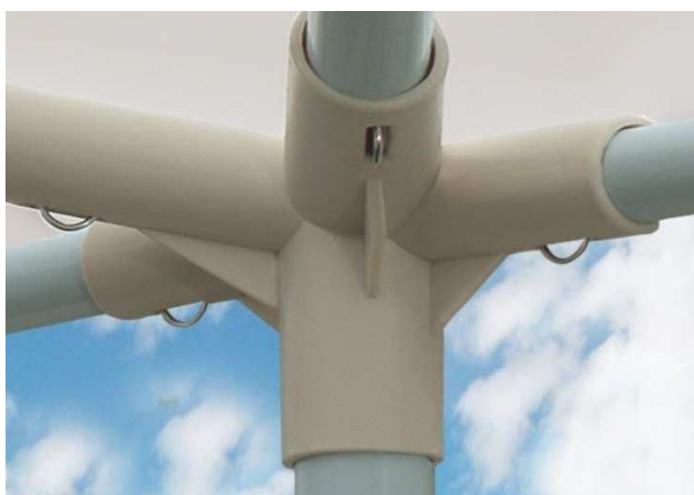
Figura 2-13: Particolare costruttivo "Snap-fit" Gazebo
