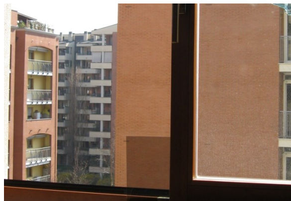
Fig.061 – Affiancamento del dispositivo filtrante ad una vetrocamera priva di depositi superficiali.
