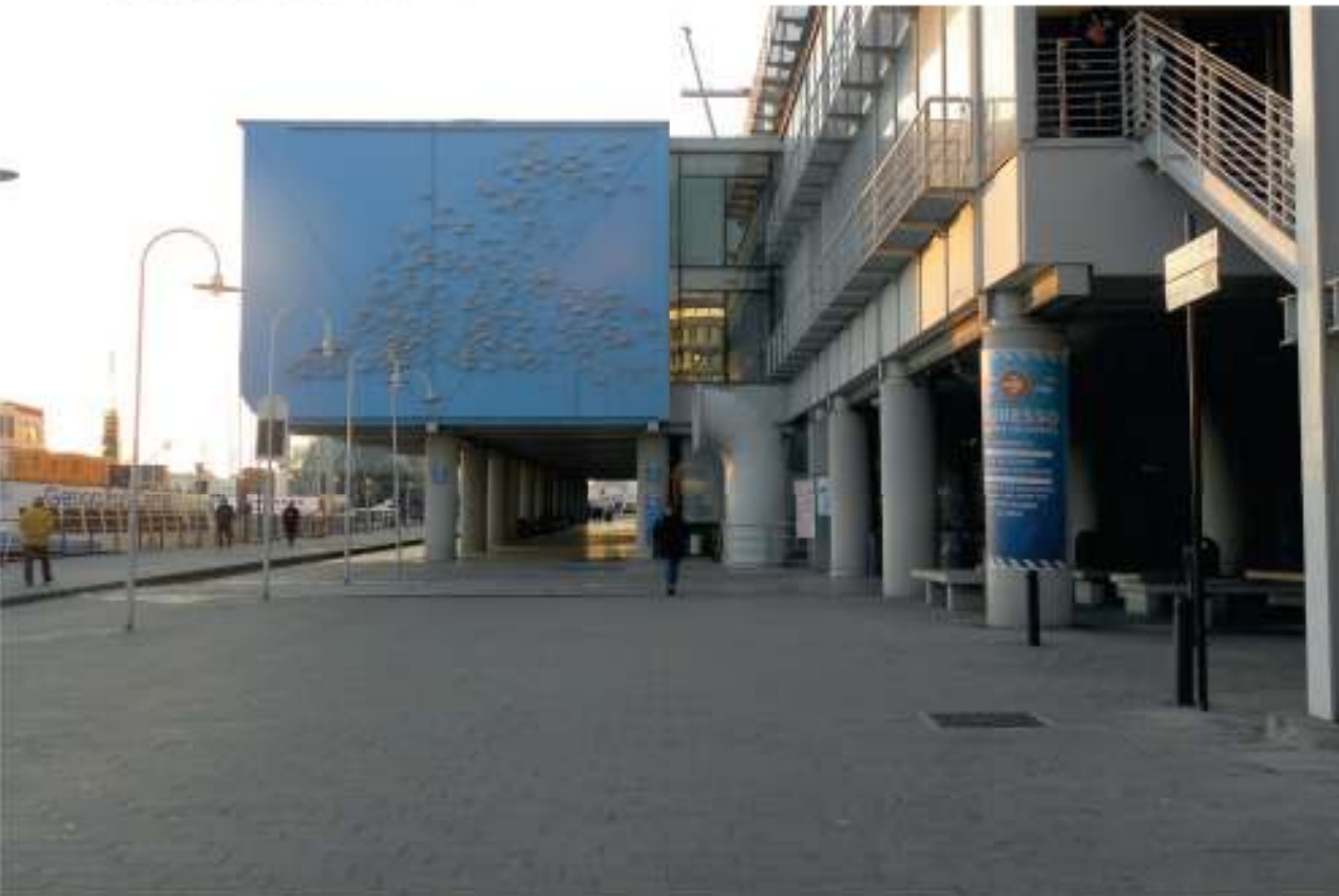
#39 Inquadramento del luogo #40 Ponte Spinola/Acquario di Genova
