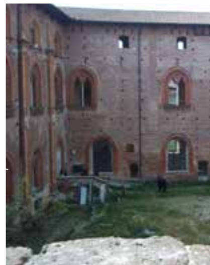
● [INGRESSO DAL CORTILE]
