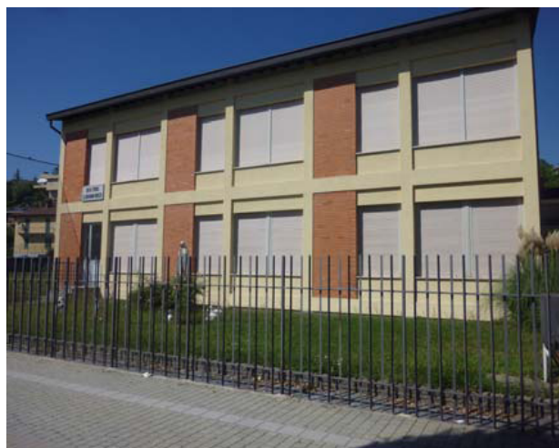
(Fig.55) l'edificio dell'oratorio - oggi
