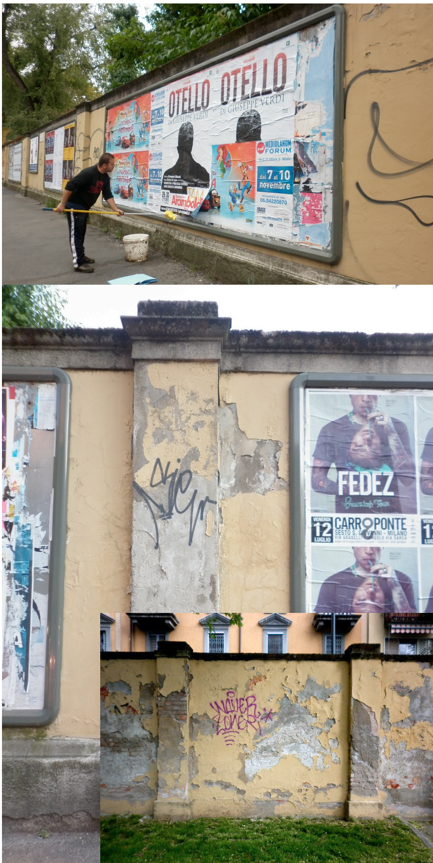
Figura 141. Muro perimetrale. Piscina Romano. 07/2013.
