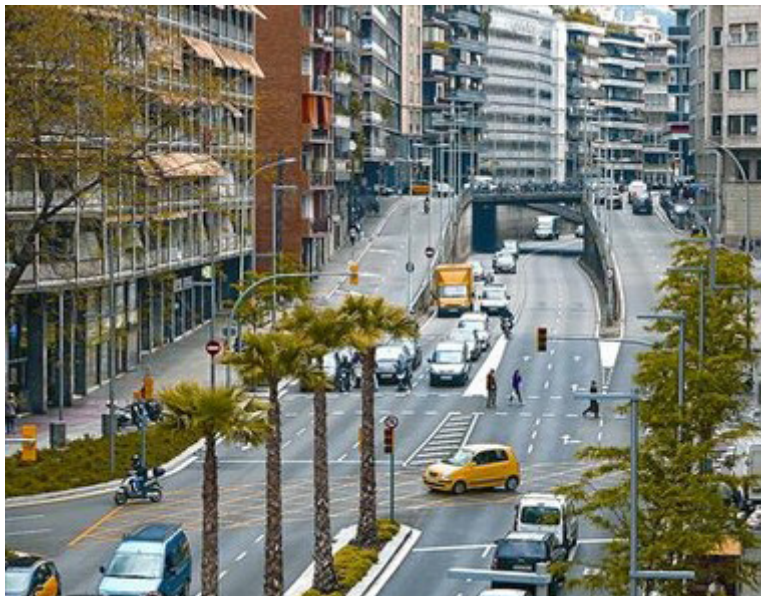
1994-1997_ Jordi Henrich, Olga Tarrasó Cobertura de la Ronda del Mig, Carrer Brasil, Barcelona, Spain
