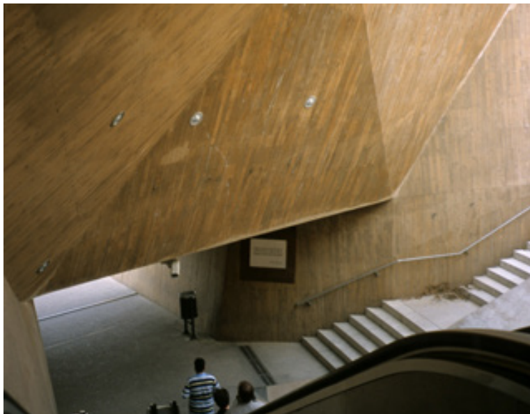
2000_Martinez Lapeña, Torres Tur Escaleras de la Granja, Toledo, Spain
