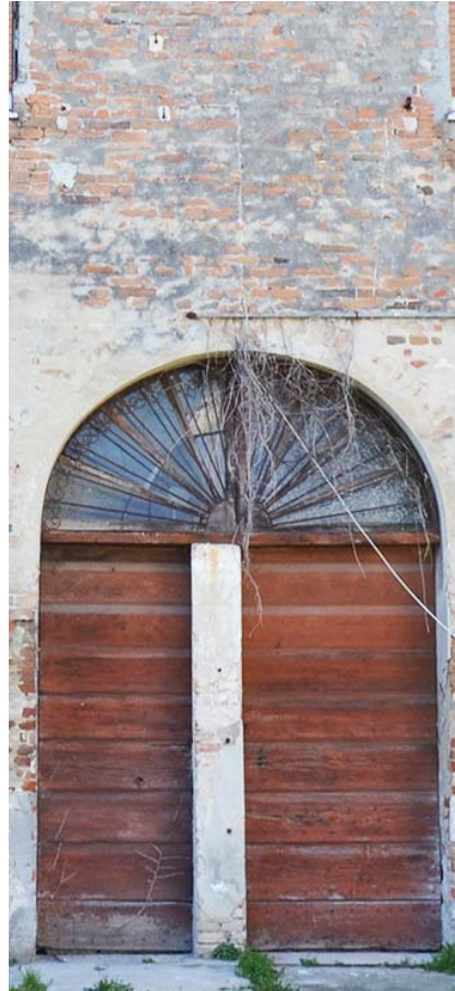
Fig. 2.18 Portone sul fronte strada.
