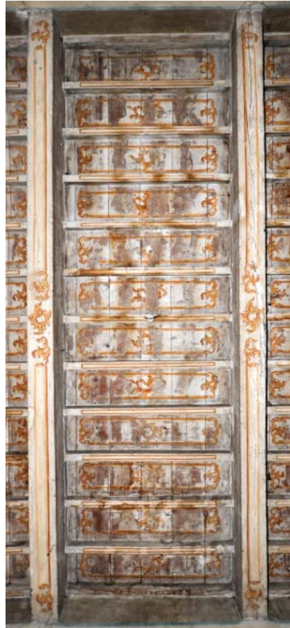
Fig. 2.8 Particolare della decorazione policroma del soffitto ligneo in corrispondenza dell'andito al primo piano dell'alloggio a nord.
