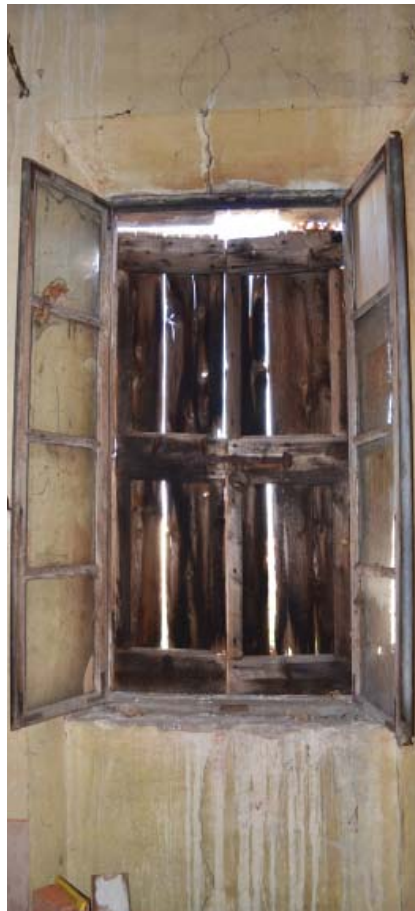
Fig. 2.14 Finestra con battuta centrale a gola di lupo, di probabile installazione settecentesca.
