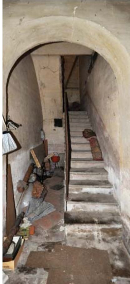
Fig. 2.12 Prima rampa della scala originaria in cotto.
