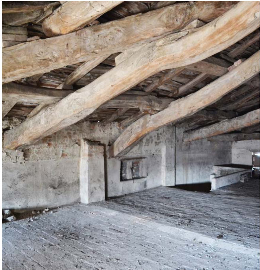
Fig. 2.11 Orditura della copertura ricavata da fusti curvilinei di pioppo.
