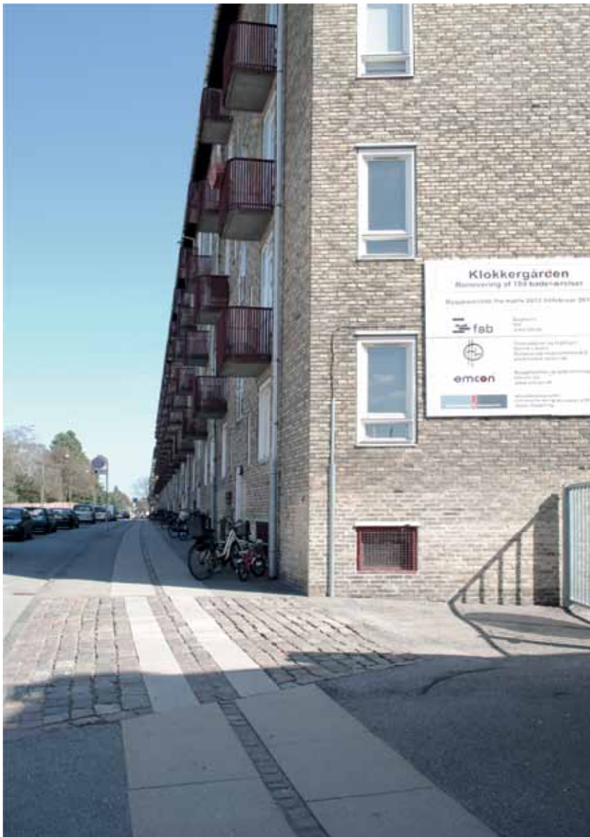
Figura 61. Klokkergården, accesso esterno lato est
