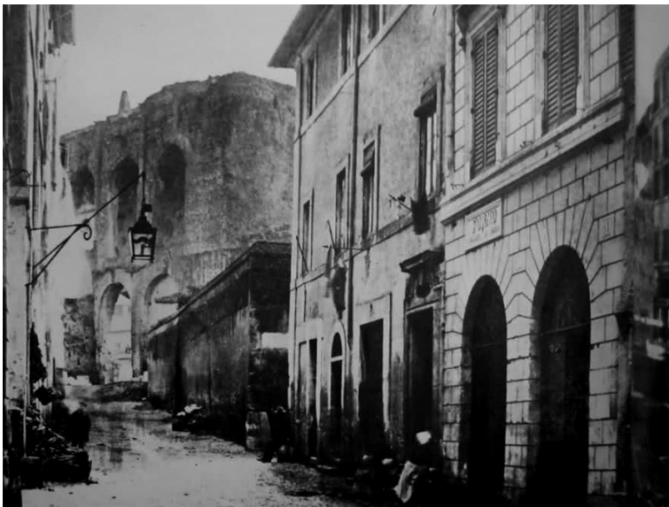
fig.21 Vista della Basilica di Massenzio da via Alessandrina.
