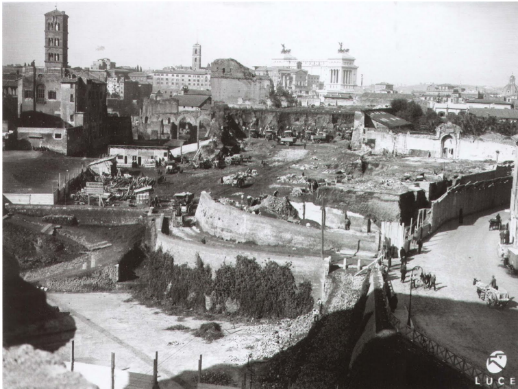
fig.34 Situazione degli scavi al 1932.
