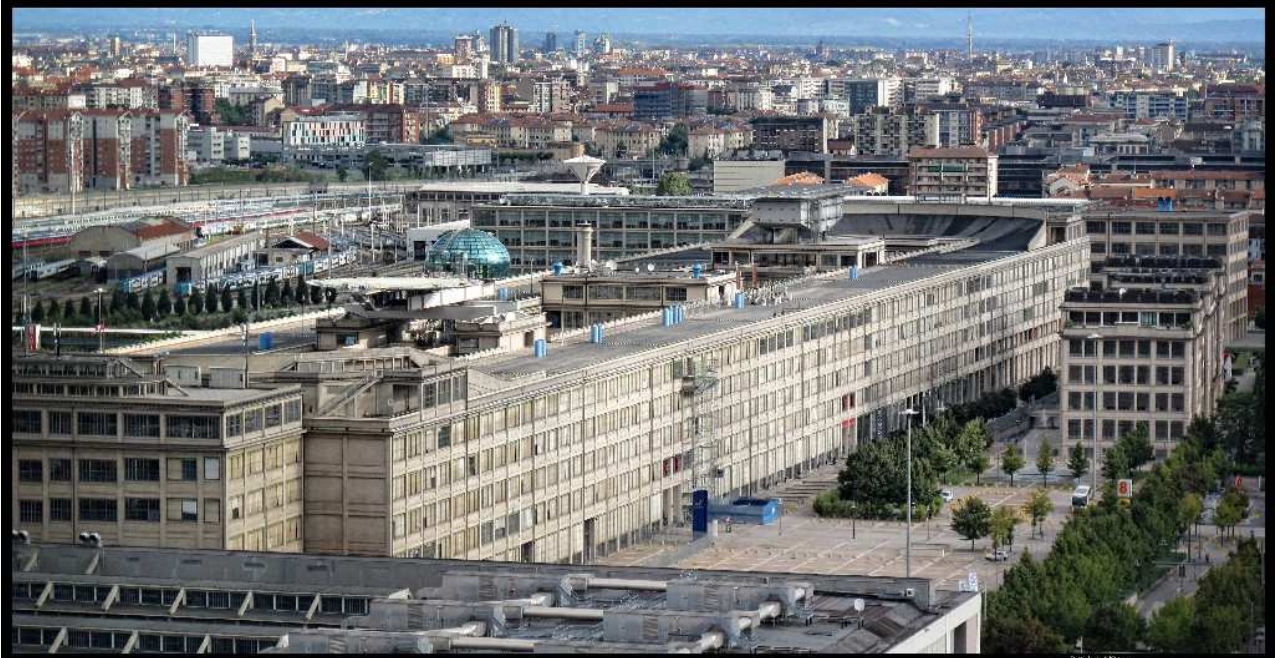
16 vista esterna del Lingotto
