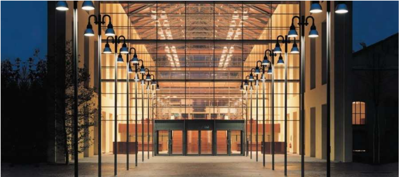
18 parete vetrata dell'auditorium Paganini
