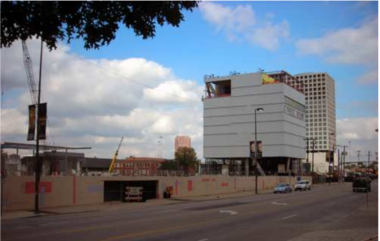
26 cantiere del Wyly Theatre
