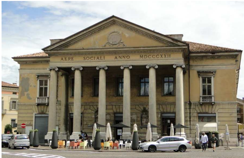
7 facciata del teatro sociale di Mantova
