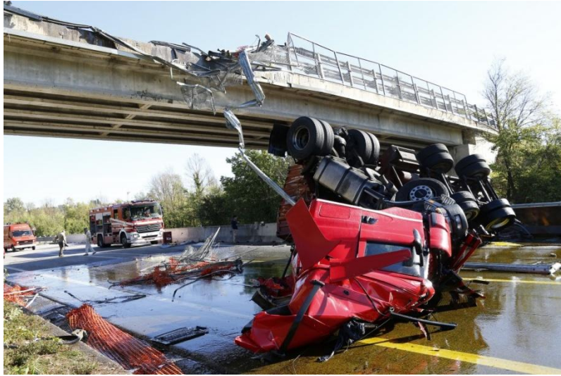
Figura i. Esempio di incidente dovuto al malfunzionamento di una barriera di bordo ponte (Siena, 13 ottobre 2013).
