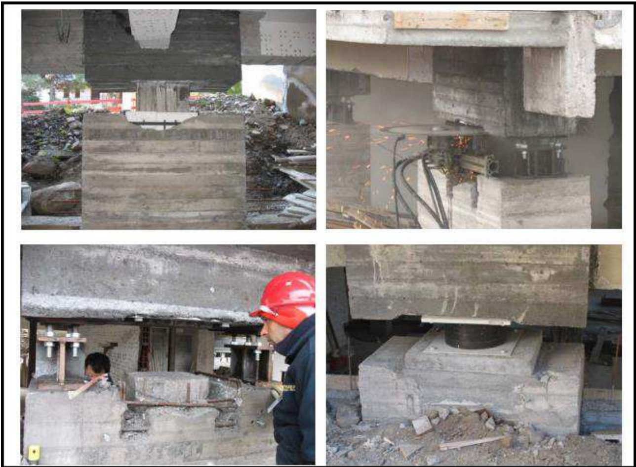
Figura 78 Fasi realizzative preliminari al taglio dei pilastri ed inserimento degli isolatori
