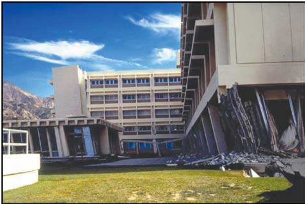
Figura 43 Effetti del sisma del 1971 sull'Sylmar Olive View hospital
