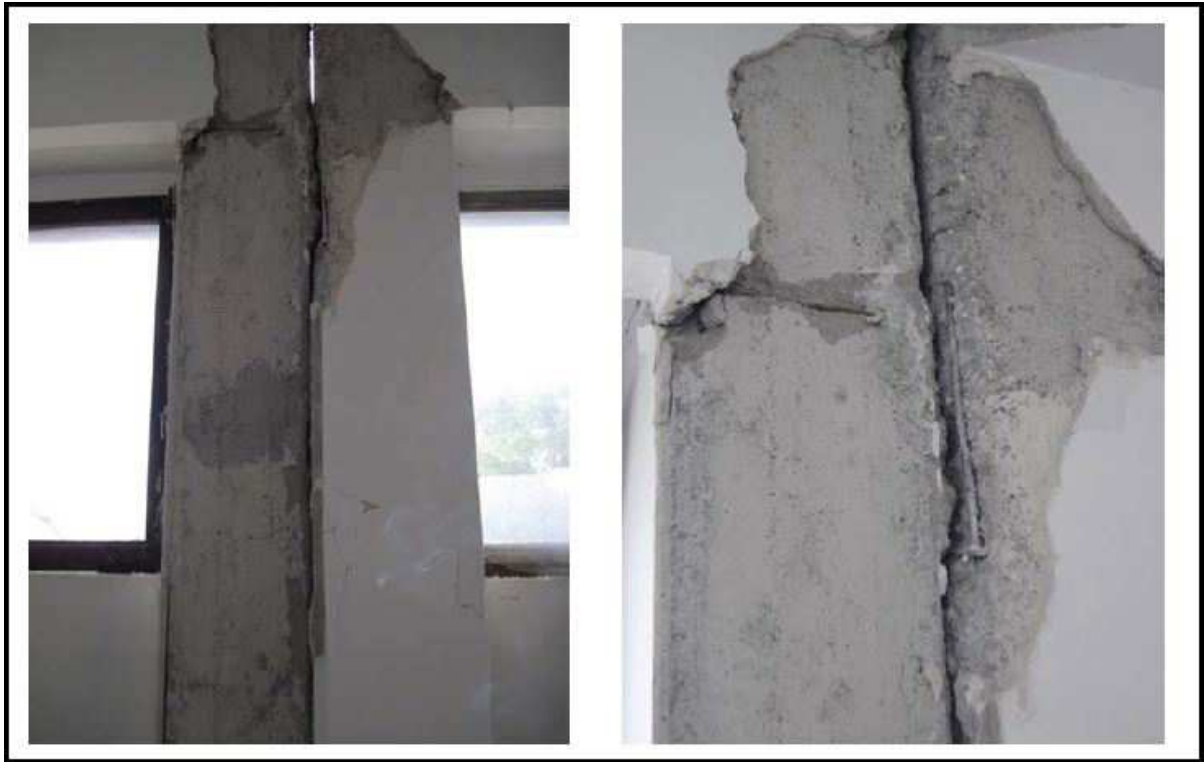
Figura 99 Fenomeni di martellamento del giunto
