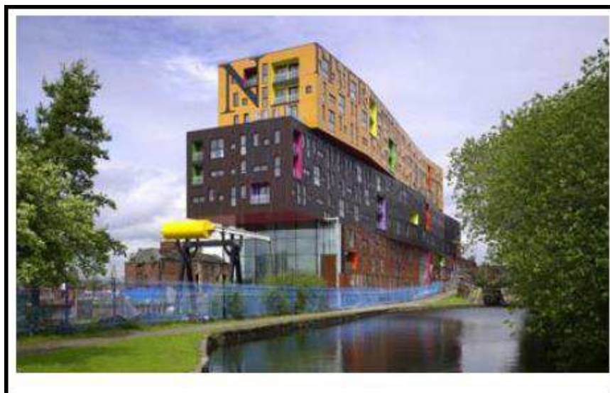
Figura 9 Irregolarità con grandi rientranze nella struttura
