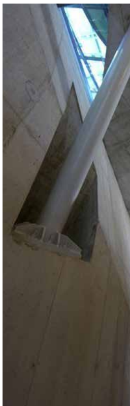
10_Ancoraggio pilastro
