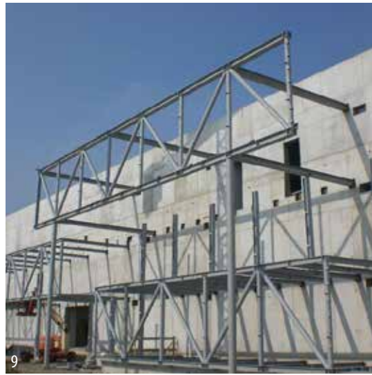
8,9_Fasi di realizzazione delle strutture inacciaio.
