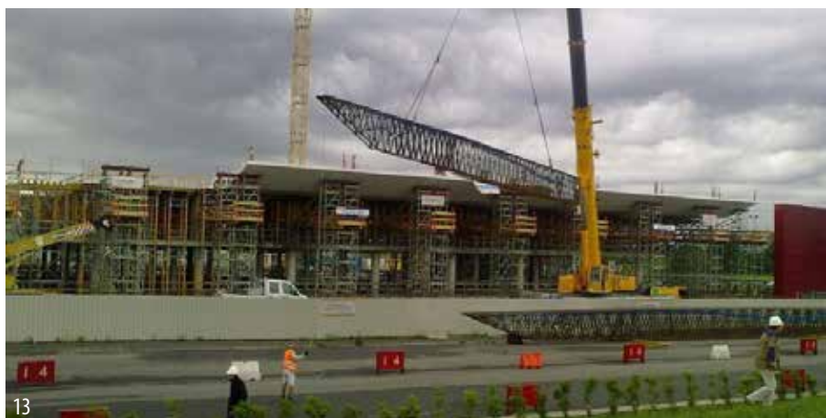
13,14 Messa in opera delle strutture, posa dell'armatura di una trave di copertura.
