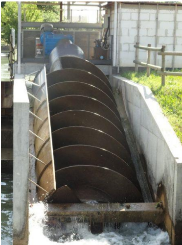
Figura 18 - Vite di Archimede
