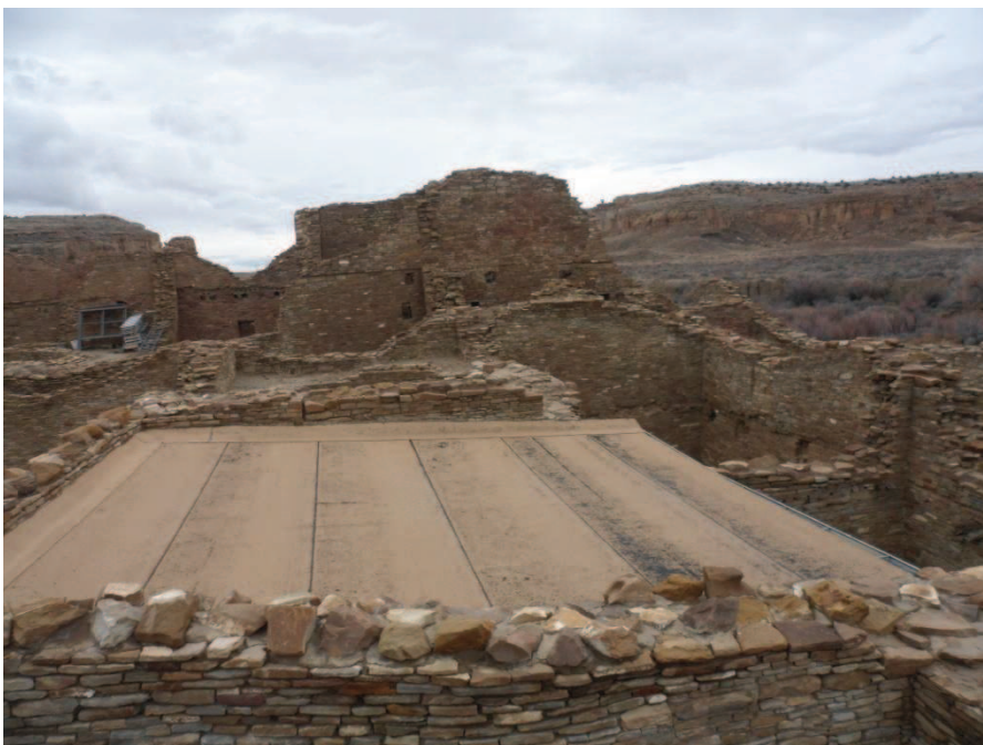
Immagine 20_Copertura protettiva a Pueblo del Arroyo
