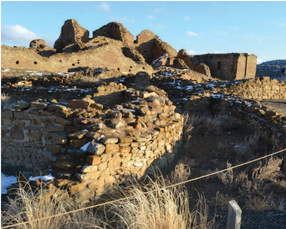
Immagine 18_Esempio di “wall capping” a Pueblo del Arroyo
