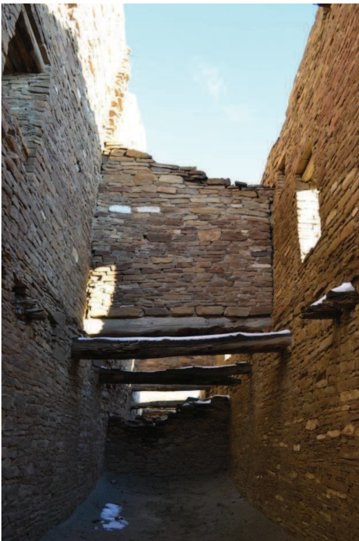
Immagine12_Pueblo del Arroyo, muro sorretto da trave
