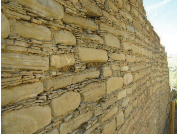
Immagine 17_Esempio di muratura alla quale sono state sostituite alcune pietre
