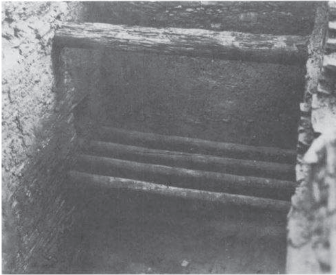
Immagine 14_ Travi primarie di una stanza con soppalco, Chetro Kelt
