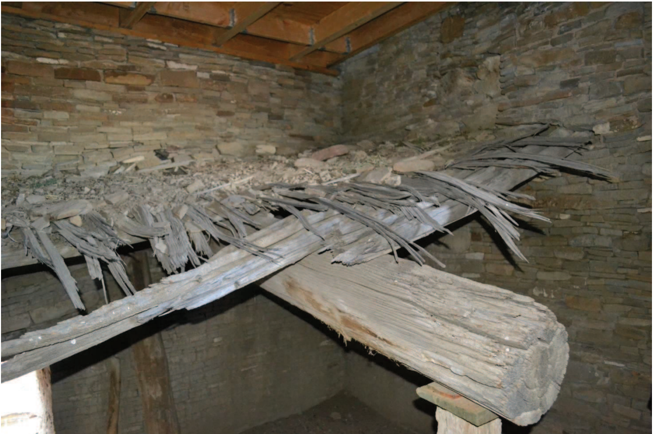
Immagine10_Pueblo del Arroyo, copertura originale
