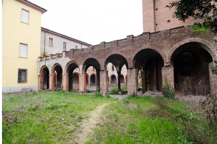
Figura 3 I chiostrini della chiesa, prossimi a Piazza Casali
