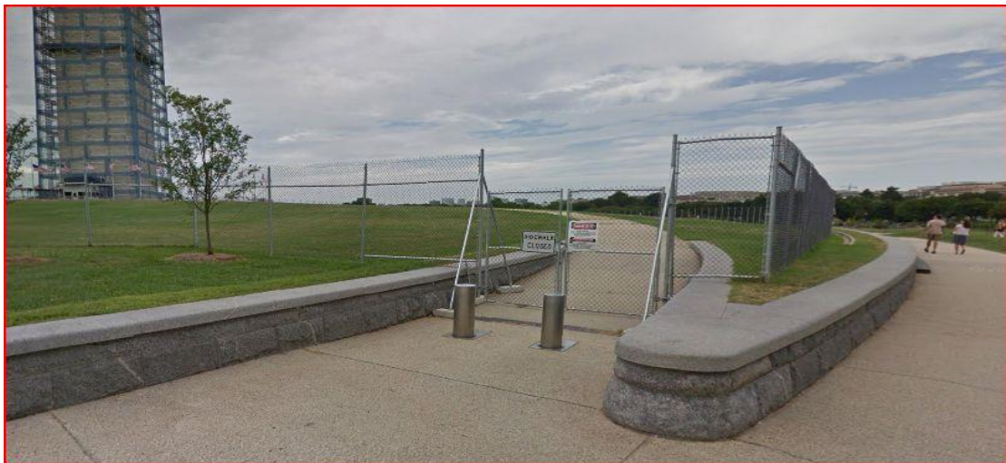
Figura 116. Percorso di accesso all'area "sicura" del monumento a Washington, la recinzione è presente perché al momento della foto erano in corso lavori di manutenzione. Si nota la presenza di una coppia di bollards retrattili per posti in corrispondenza sentiero di accesso.
