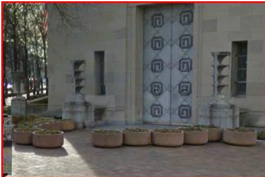
Figura 105. Portone di entrata al dipartimento di giustizia, protetto da una serie di fioriere con la funzione di bollards che ne impediscono l'accesso frontale, obbligando gli utenti ad un avvicinamento laterale. Questo provvedimento è stato attuato per evitare che un automezzo riesca a forzare le barrire e possa introdursi all'interno dell'edificio (anche solo se nell'ingresso) sfruttando la grande apertura offerta dall'entrata principale.
