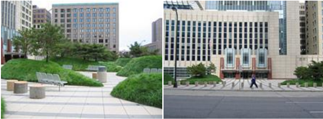
Figura 81. Federal Courthouse, Minneapolis. (31) Per assicurare una adeguata stand off distance è stata realizzata una piazza dinnanzi alla facciata principale dell'edificio. Su di essa, per scongiurare il passaggio di eventuali veicoli, sono state realizzate delle aiuole, costituite da montagne di terra ricoperte di erba e bollards in cemento.
