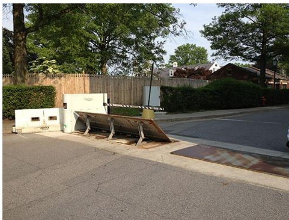
Figura 92. A destra: sezione del sistema di guide di un dissuasore retrattile ad azione manuale.(30) Alla base dell'elemento è presente una serratura che funge da blocco quando il braccio è in posizione. Figura 93. A sinistra: vista del sistema di sollevamento di una plate barrier posizionata in un checkpoint all'ingresso di un'area protetta. (automaticbollards)
