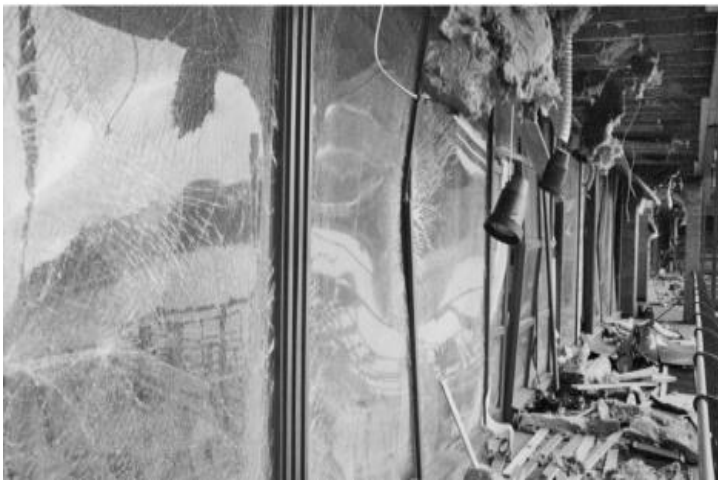
Figura 53. Rottura di diverse tipologie di vetri. (2)
