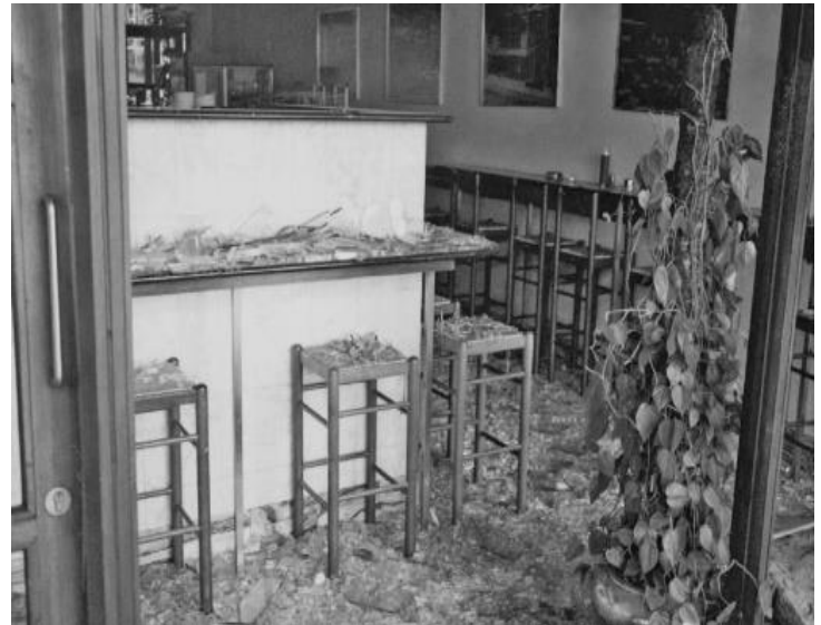
Figura 54. Rottura vetro monolitico. (2)
