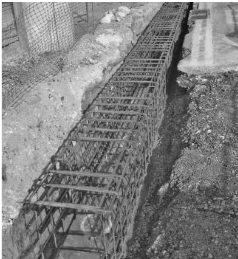
Figura 97. Gabbia di armatura di un elemento di fondazione per una linea di dissuasori statici. (2)
