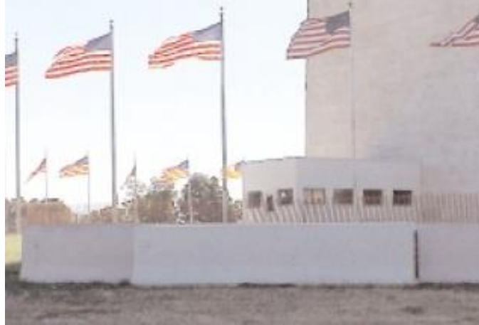
Figura 115. Particolare di una muraglia di barriere jersey a difesa del Monumento a Washington. (36)
