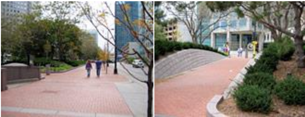
Figura 82. Hennepin County Courthouse, Minneapolis. (31) Per evitare l'intrusione nella stand off zone sono state realizzate delle banchine in cemento in cui sono stati piantati degli arbusti di modeste dimensioni. Nell'immagine a destra si nota la presenza di un singolo dissuasore al centro del passaggio pedonale, per evitare che venga percorso da autoveicoli.
