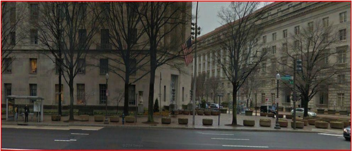
Figura 102. Situazione esistente: si può notare una fitta linea di barriere realizzate mediante fioriere in cemento posizionate lungo il bordo del marciapiede. Lavorano per gravità e sono prive di un sistema di fondazione, sono un sistema molto veloce da installare e possono rappresentare un'alternativa architettonicamente accettabile alle barriere jersey.
