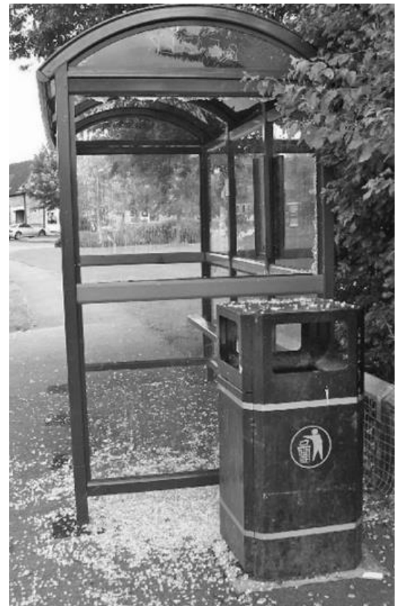
Figura 55. Rottura vetro temprato.(2)
