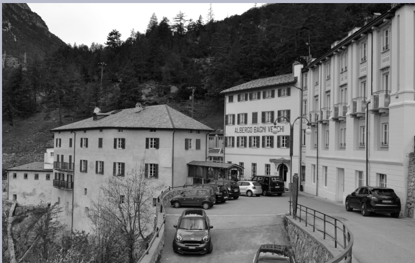
L'attuale struttura termale.
